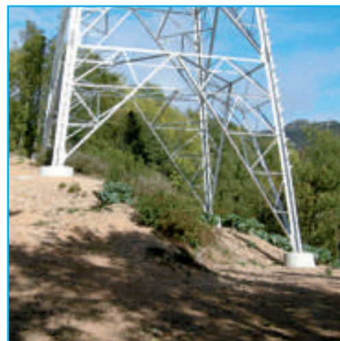
Apoyo con patas desiguales adaptadas al terreno en la comarca de La Selva.
