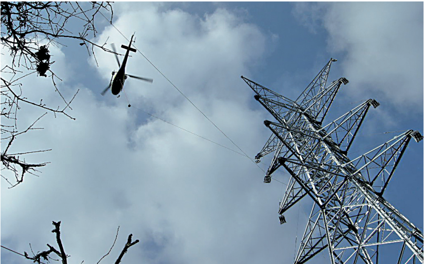
Tendido con helicóptero.
