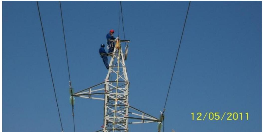
L/66 kV Vallurgent-Andratx (Mallorca). Tendido de cable de tierra con fibra óptica.
