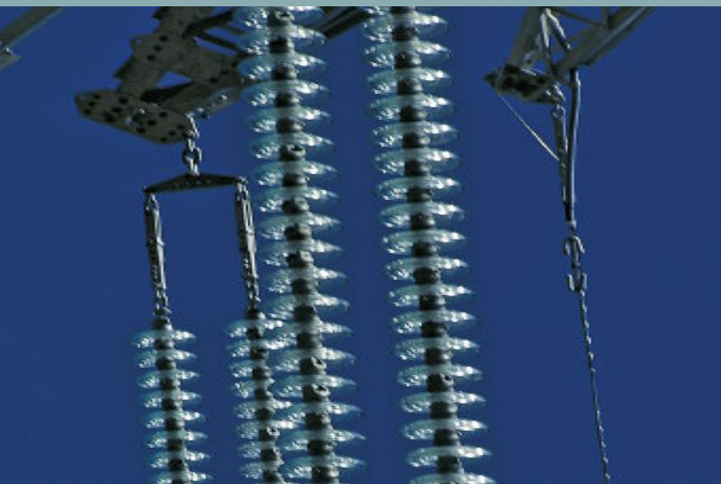
Red Eléctrica own transmission grid
