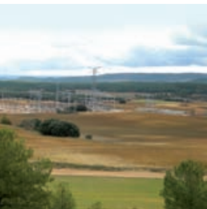
Villanueva de los Escuderos under construction.
