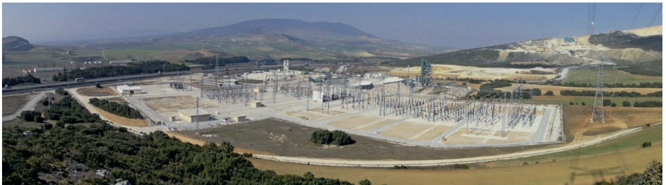
Subestación de Muruarte.
