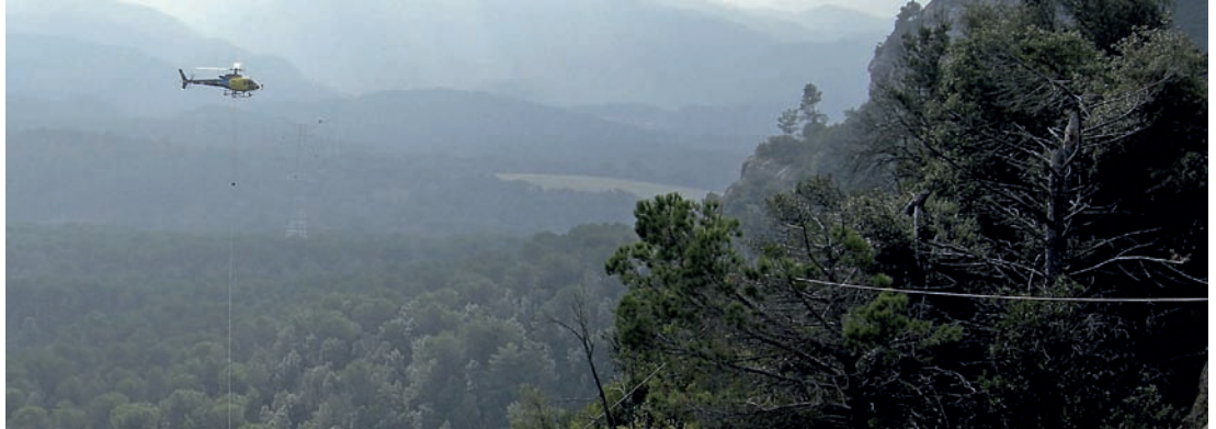
L/400 kV Setmenat-Vic-Bercarnó. Tendido con helicóptero.
