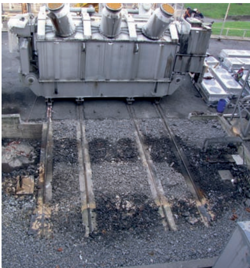
Acondicionamiento de foso de recogida de aceite en máquina de potencia.
