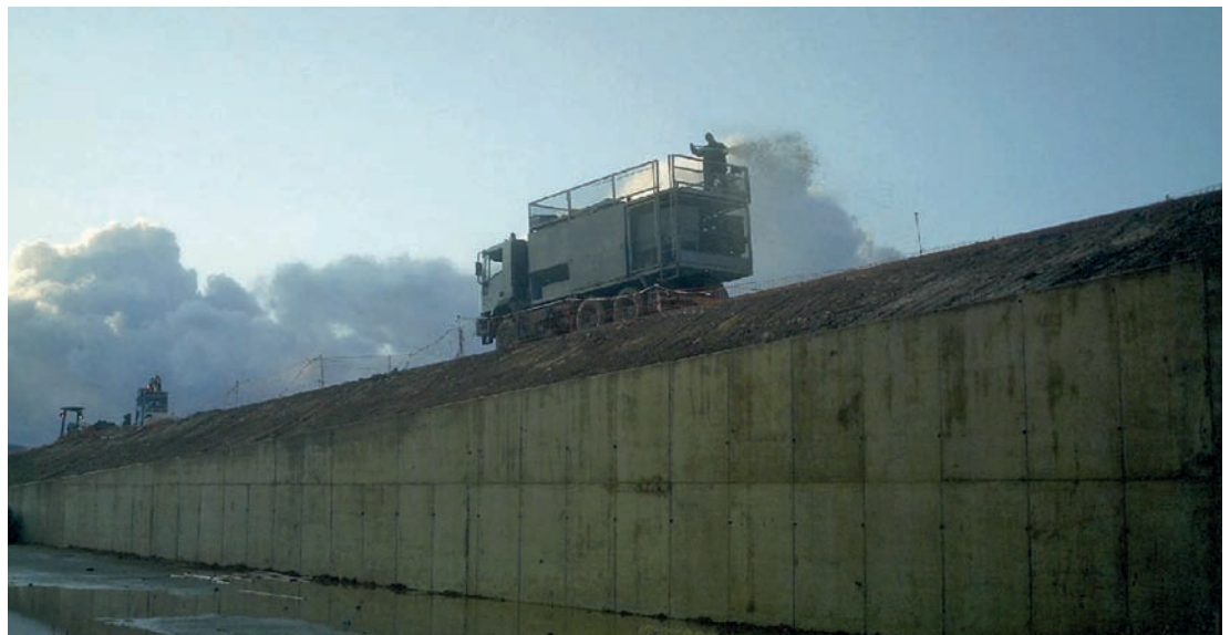
Hidrosiembra Subestación de Pesoz.
