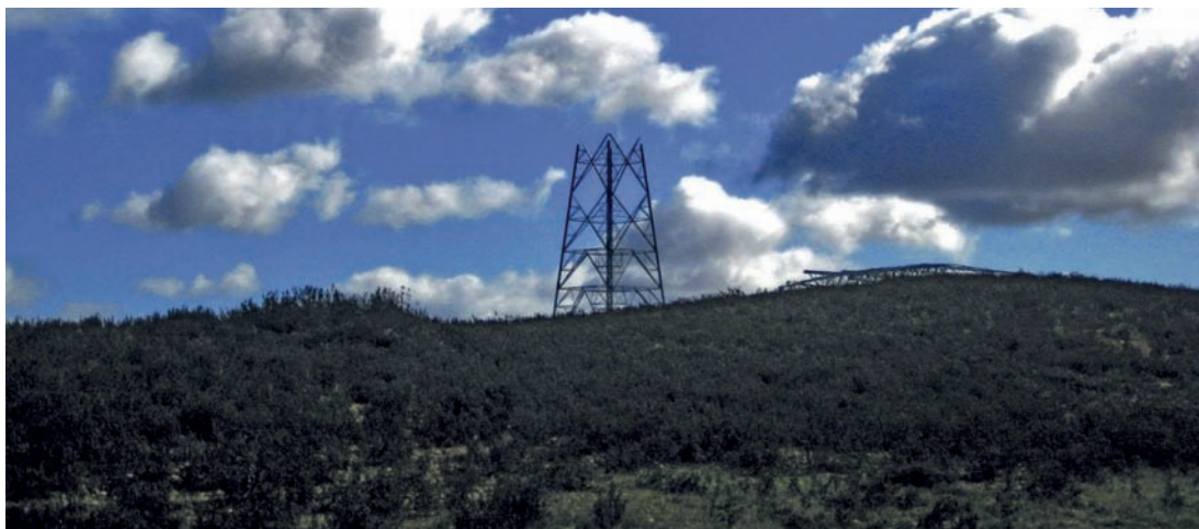
Línea de 220 kV en construcción. Puebla de Guzman.
