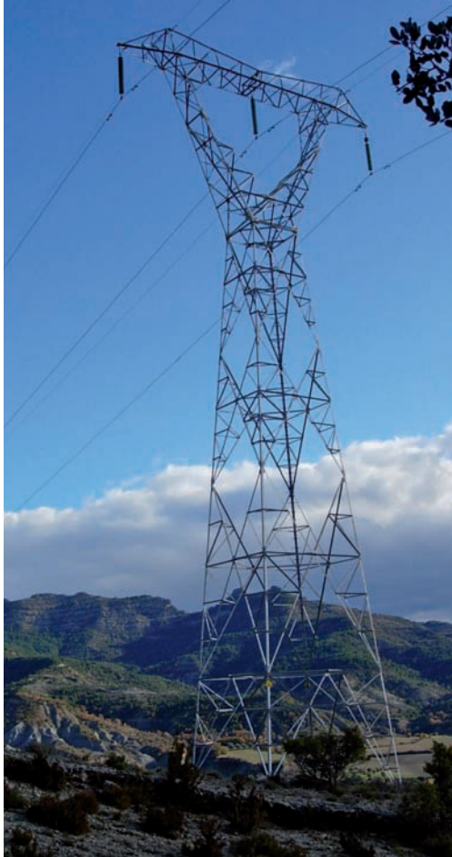
220 kV Line La Pobla-Escalona.
