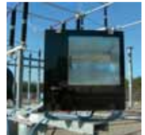
Detalle de luminaria de S.E.
