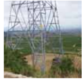
Apoyo de entronque a la línea eléctrica desde la SE. Haro
