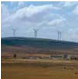
SE. Lora. (Evacuación de energía del parque eólico.)
