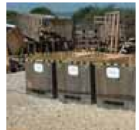
Zona de almacenamiento de residuos en obra
