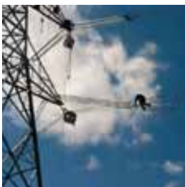
Tendido del cable eléctrico de la L/Castejón-Muruarte.
