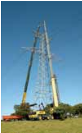
Izado de un apoyo con grúa.
