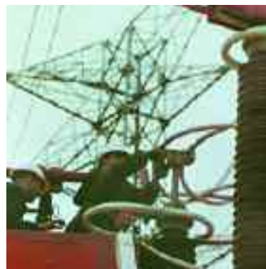
Operarios trabajando en líneas
