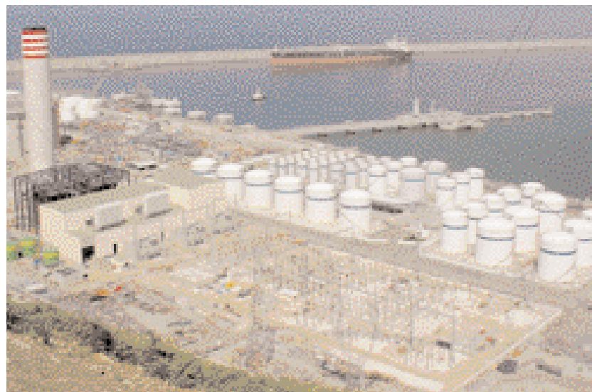
Subestación de Zierbena
