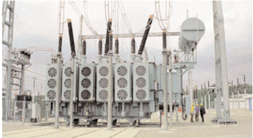
Transformador de potencia de 400 kV a 110 kV y 300 MVA, con foso de recogida de aceite. Subestación Calders.
