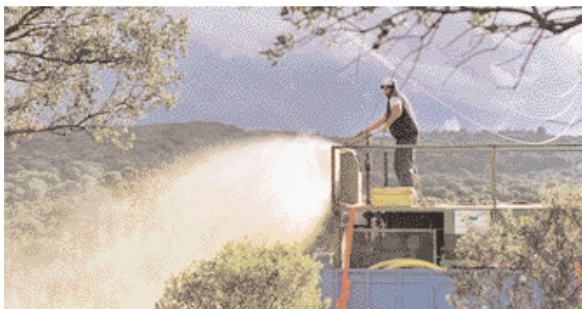
Hidrosiembra realizada en la línea Trillo-Calatayud
