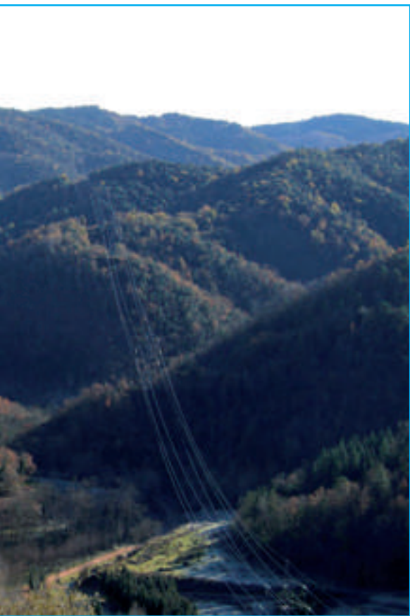
Línia de 400 kV Sentmenat-Bescanó, al seu pas pel parc natural de Les Guilleries.
