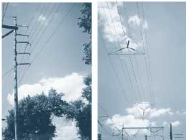
Figura 9. Configuraciones de fase partida vertical (izquierda) y hexagonal (derecha) para 115 kV.
