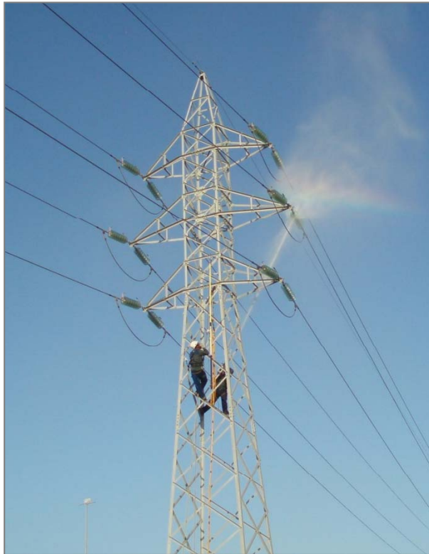
Limpeza de cadenas de aisladores con camión y helicóptero en Gran Canaria.
