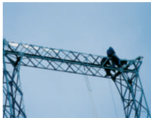
Instalación de disuasores de nidificación
