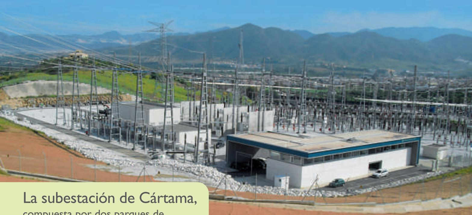
La subestación de Cártama, compuesta por dos parques de 400 y 220 kV, constituye junto con las subestaciones Tajo de la Encantada y Jordana los tres nudos fundamentales de la red de transporte de energía eléctrica de la provincia de Málaga y supone una instalación de vital importancia para garantizar el suministro eléctrico de su capital y su entorno metropolitano, así como para alimentar al tren de alta velocidad en el tramo Córdoba-Málaga.
