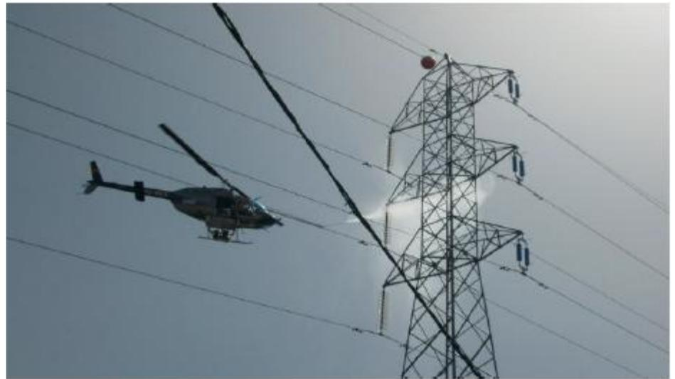
Limpieza de cadenas de aisladores con camión y helicóptero en Gran Canaria.
