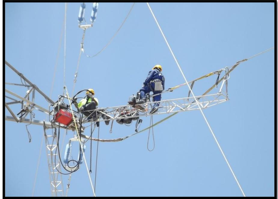
Sustitución en un tramo de 8,8 km del conductor, aislamiento y herrajes en las tres fases del circuito 66kV Granadilla-Tagoro (Tenerife)
