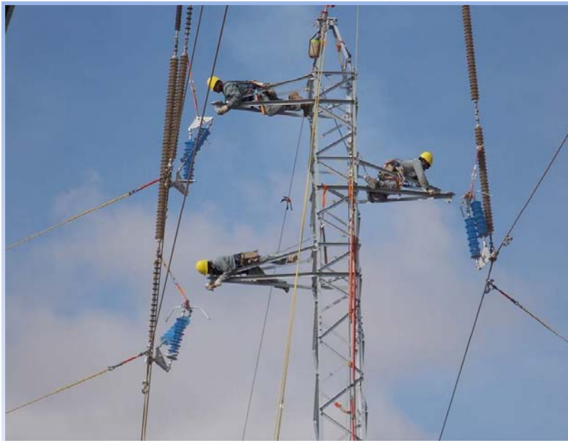
Sustitución de 18 apoyos en tensión en la línea de 66 kV Gran Tarajal-Matas Blancas (Fuerteventura)
