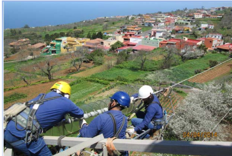
Cambio de aislamiento de vidrio a doble compuesto en la línea de 66 kV Cuesta de la Villa – Tacoronte (Tenerife)
