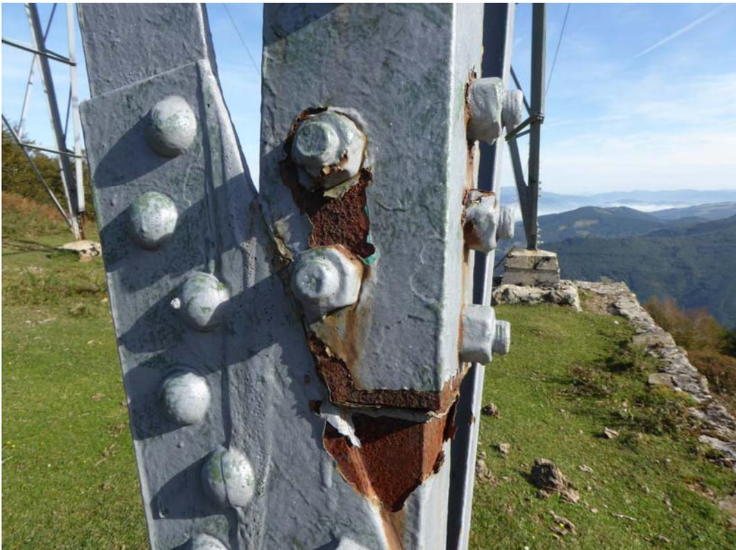
*Foto 9. Herrumbre en pata nº 1 del apoyo 424R de la línea 220 kV Elgea-Itxaso.*
