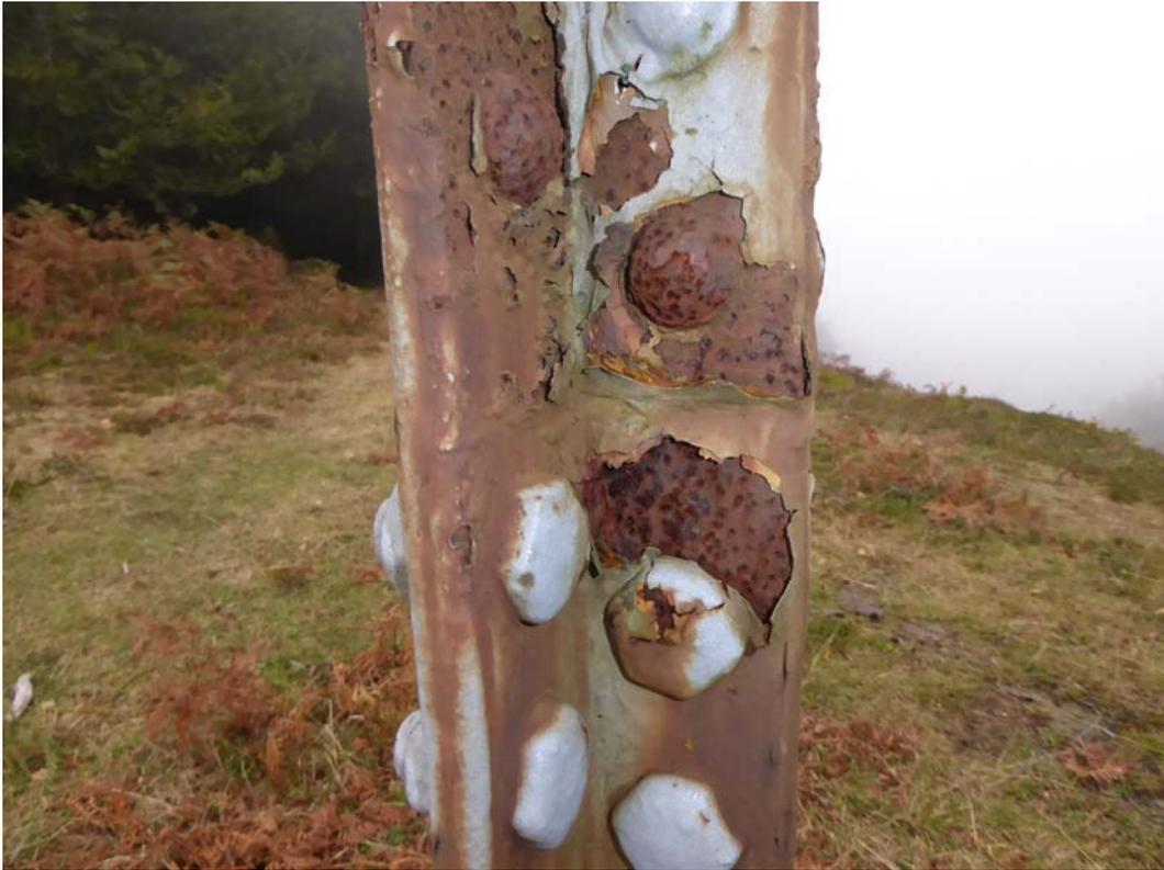
*Foto 8. Herrumbre en pata nº 2 del apoyo 418R de la línea 220 kV Elgea-Itxaso.*
