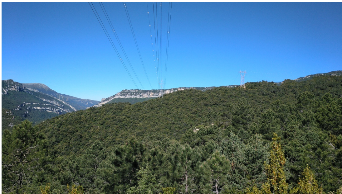
Foto 2. Vano entre los apoyos 20-21. Se ve el apoyo 20
