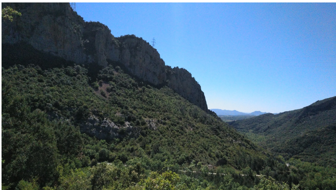
Foto 7. Panorámica donde se aprecia el apoyo 20 sobre los cortados de Sobrón
