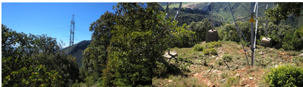
Foto 5. Último tramo del acceso al apoyo 20 y zona de trabajo
