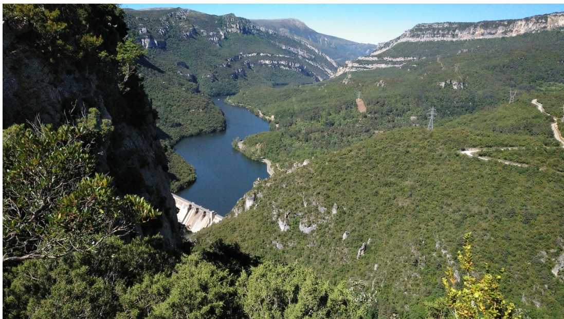
Foto 3. Vista de la cerrada del embalse de Sobrón desde el apoyo 20
