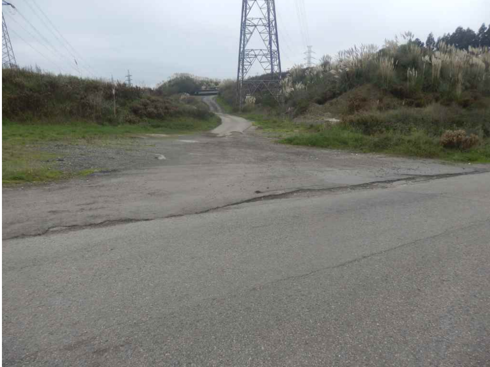
Foto 2. Vista del acceso y el apoyo T13 actual
