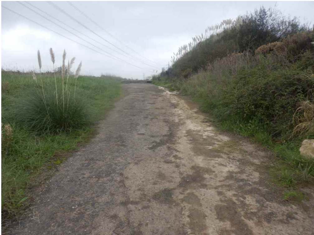
Foto 4. Camino asfaltado que se corresponde con el camino existente a acondicionar
