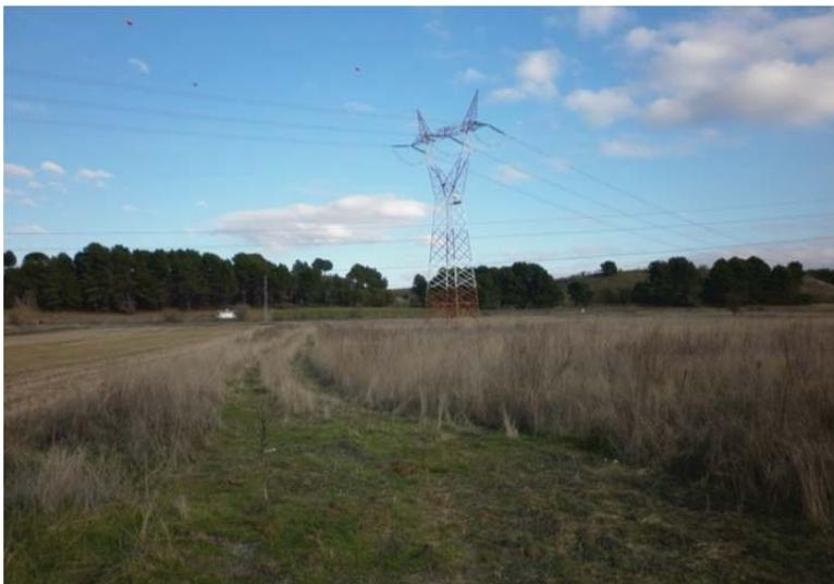
Fotografía 1.- Apoyo T-12 en la zona de cultivo por la que se propone el acceso campo a través utilizando la rodada existente.
