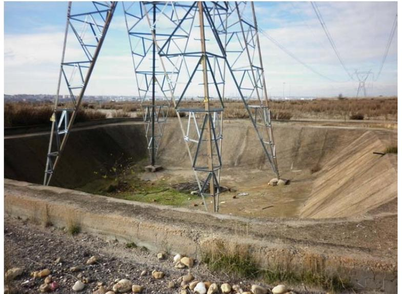
Fotografía 2.- Detalle de la plataforma deprimida en la que se asienta el apoyo en la actualidad.
