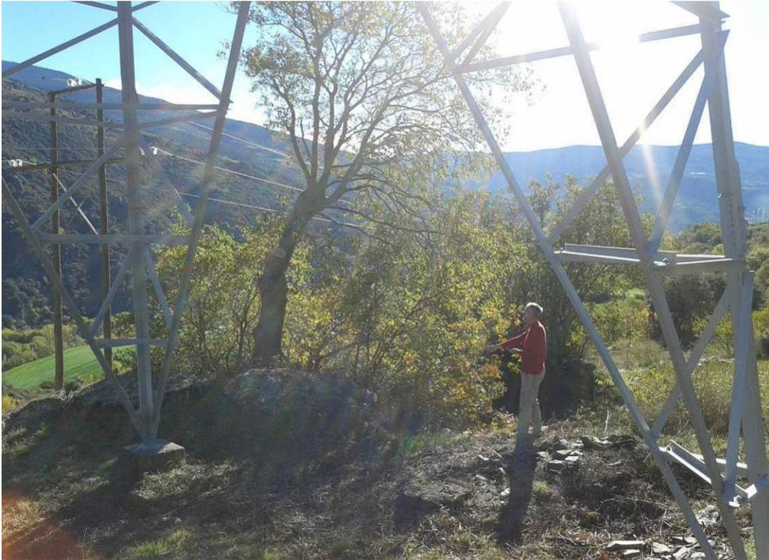
**Apoyo 27:** Se propone el recrecido de 5 m del apoyo 27, debido a que en caso de no aumentarse su altura, comprometería el cumplimiento de las distancias reglamentarias con una línea eléctrica de 25kV, en el vano 27-28.
