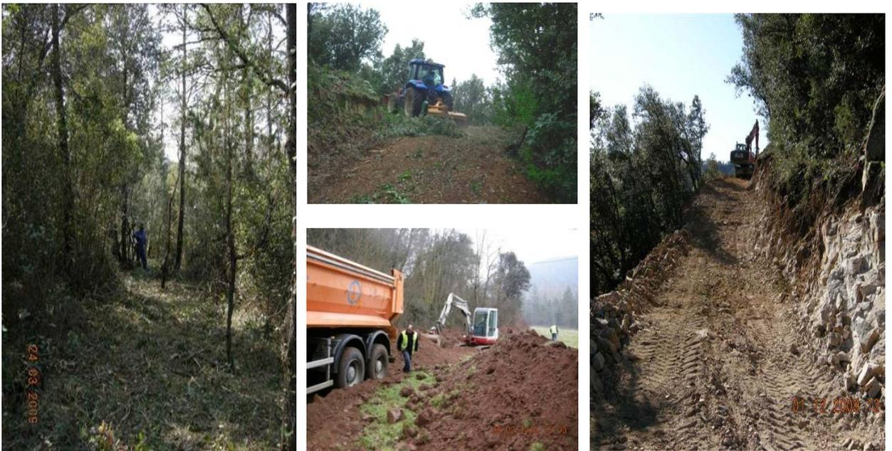
Foto 3. Fase de construcción de nuevo acceso. Fuente: Red Eléctrica
