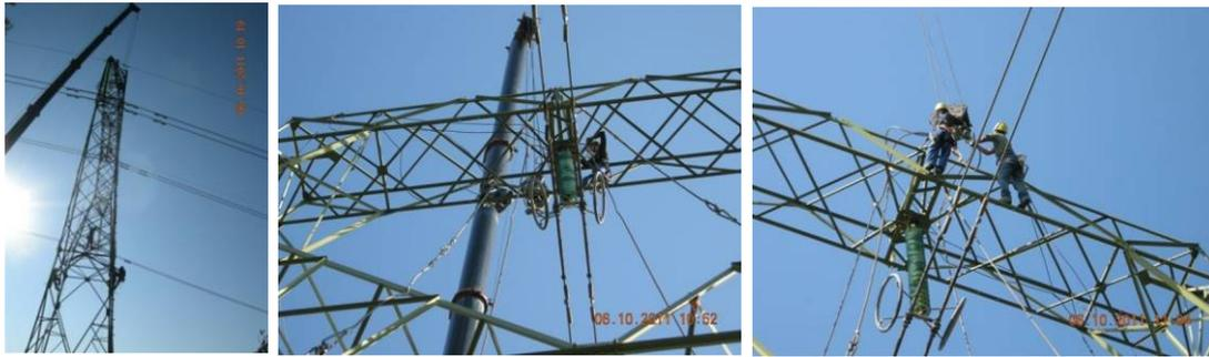
Foto 6. Ejemplo de tareas para ejecutar el recerido de los apoyos. Fuente: Red Eléctrica
