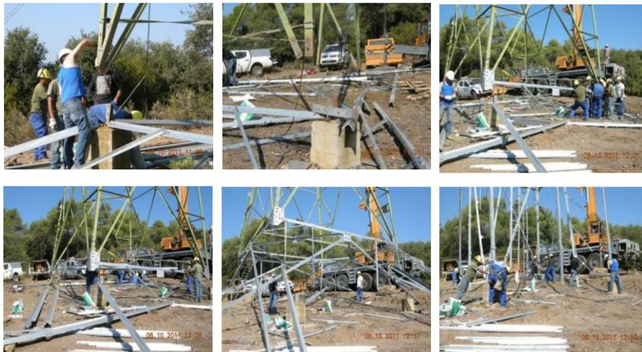
Foto 8. Ejemplo de tareas para ejecutar el recerido de los apoyos. Fuente: Red Eléctrica
