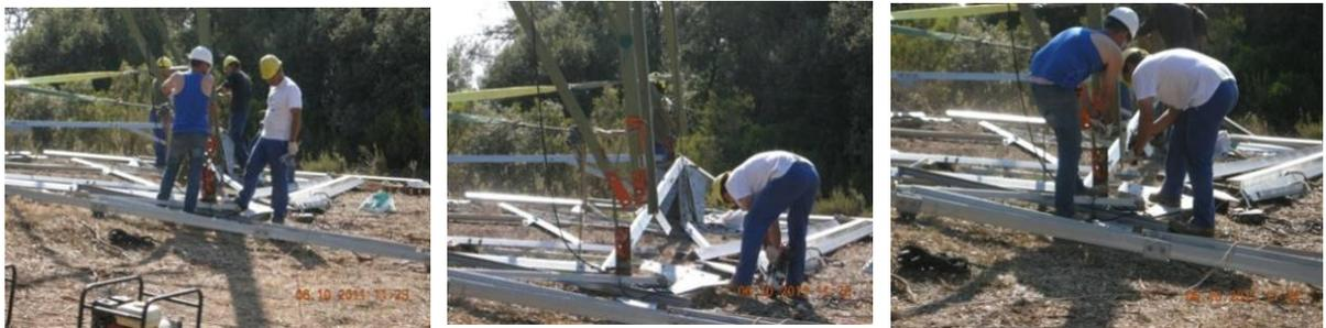
Foto 7. Ejemplo de tareas para ejecutar el recerido de los apoyos. Fuente Red Eléctrica
