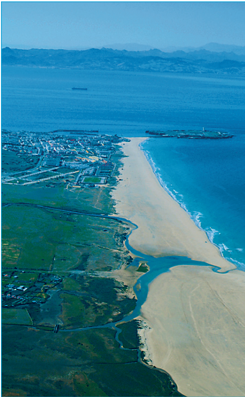
Vista aérea del estrecho de Gibraltar en la que se aprecia la estación terminal de Tarifa, alejada de los núcleos urbanos
