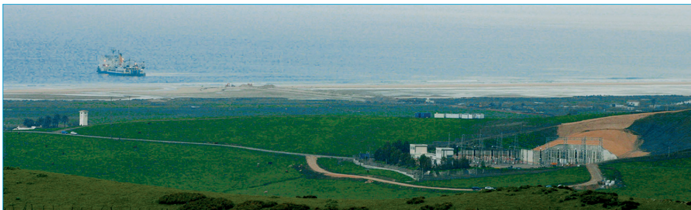
Estación terminal de Tarifa y barco que realiza el tendido del cable submarino
