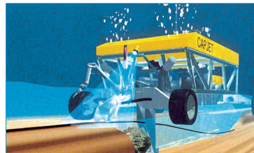
Simulación del proceso de enterramiento de los cables en el fondo marino
