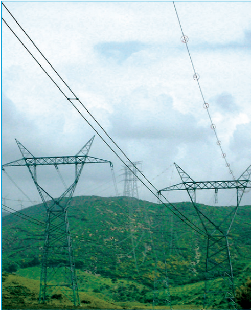
Línea aérea que enlaza con la estación terminal de Tarifa
