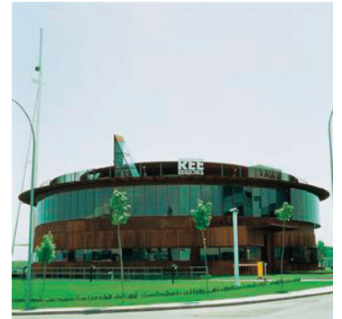
Escuela Corporativa de Red Eléctrica (ECRE) en Tres Cantos (Madrid)
