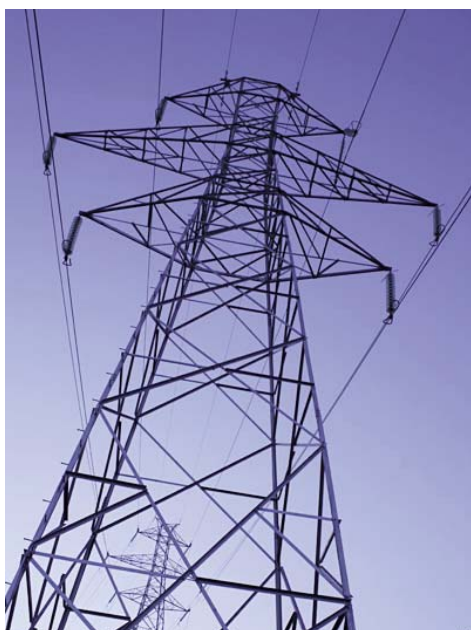
Línea eléctrica de alta tensión (AT).
