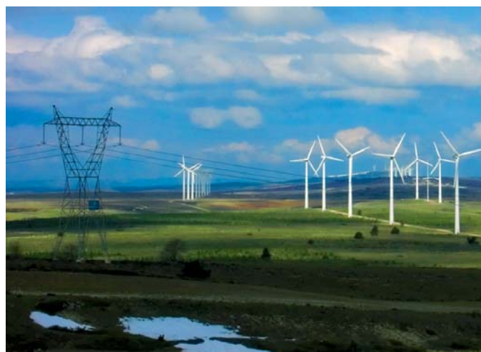
Línea de alta tensión y parque eólico.
