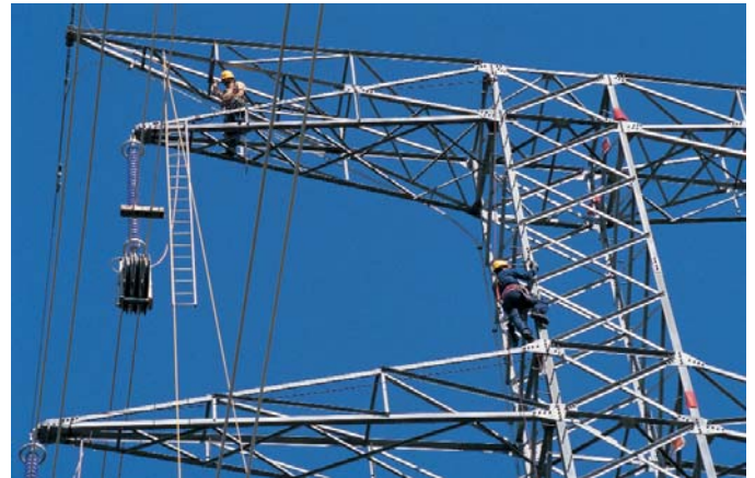
Tendido de cable de alta tensión.
