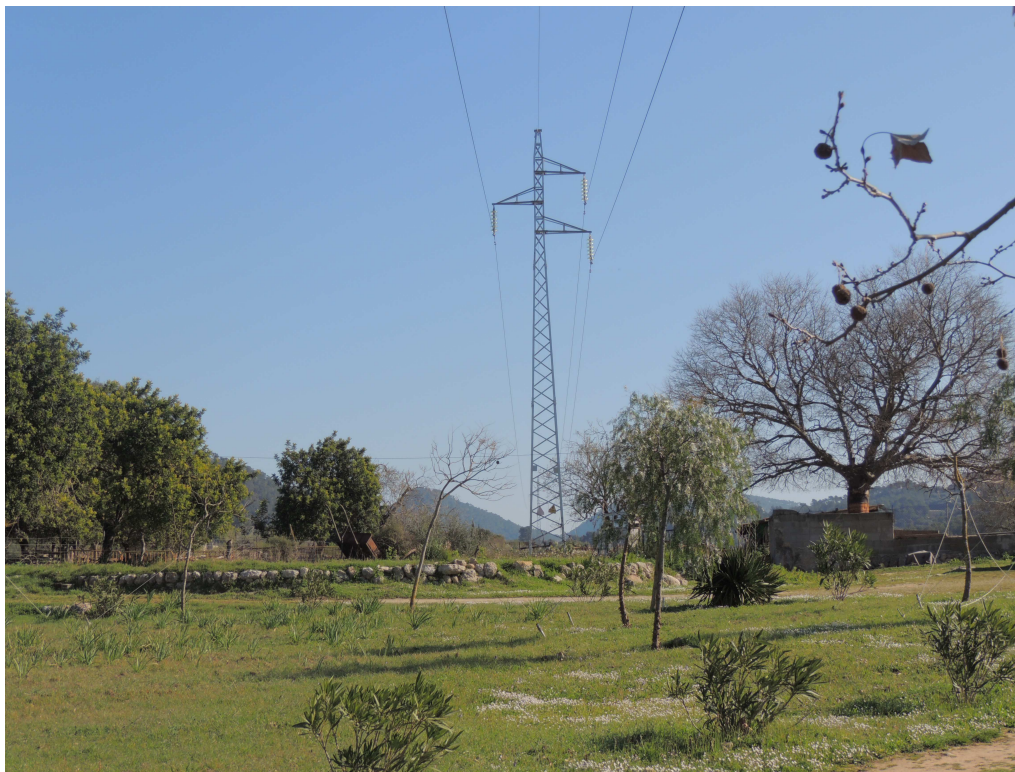
FOTOGRAFIA 11. Algunos apoyos se ubican cerca de eras. Deberá evitarse la afección al patrimonio etnológico en el momento de las obras (Apoyo T-52)
