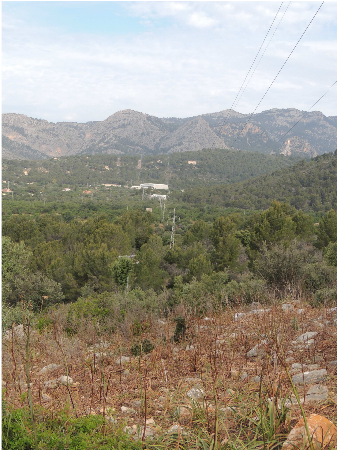
FOTOGRAFIA 19. La última alineación de la línea eléctrica afecta zonas boscosas y campos de cultivo de secano hasta llegar a la subestación eléctrica de Bunyola. Vista desde el apoyo T-100 (apoyos T-101 a T-105).
