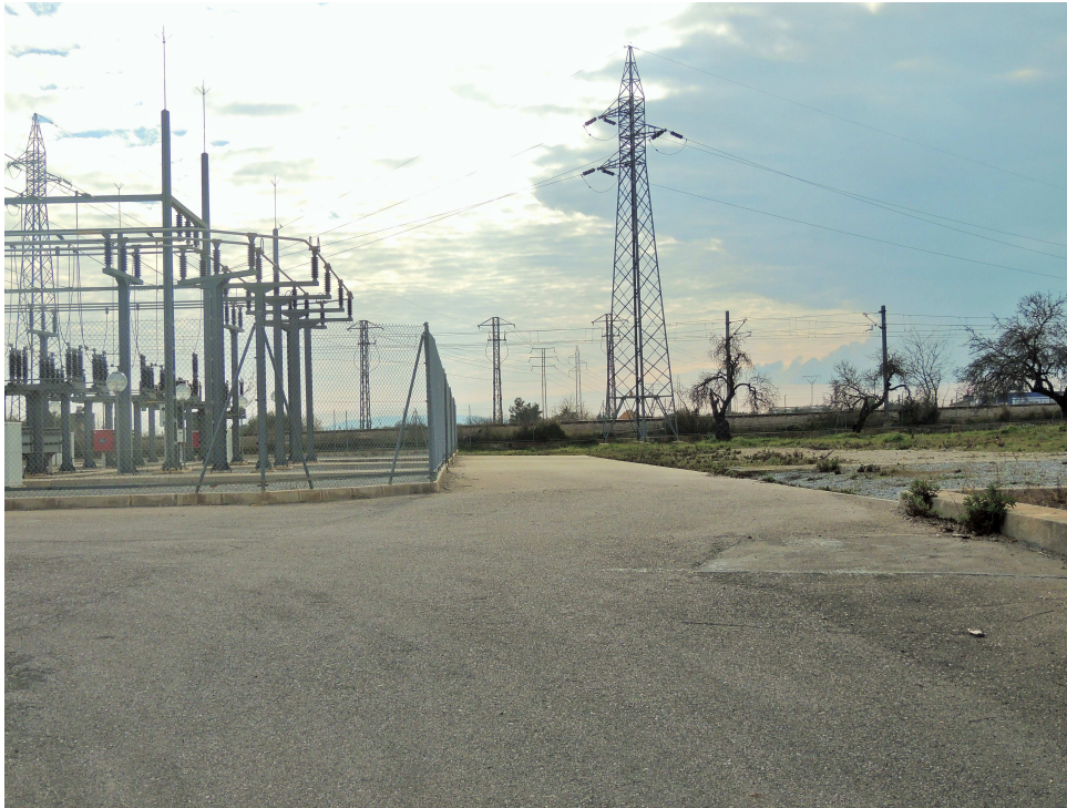
FOTOGRAFIA 1. Subestación de Inca (Apoyo T-01)
