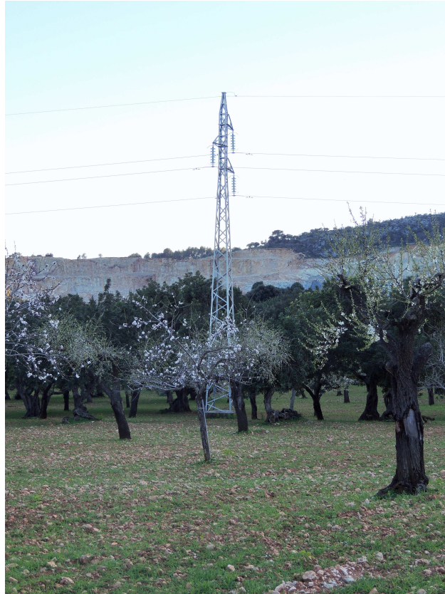
FOTOGRAFIA 7. La línea queda muy próxima a la cantera de Can Negret de la cementera Cemex (apoyo T-36).
