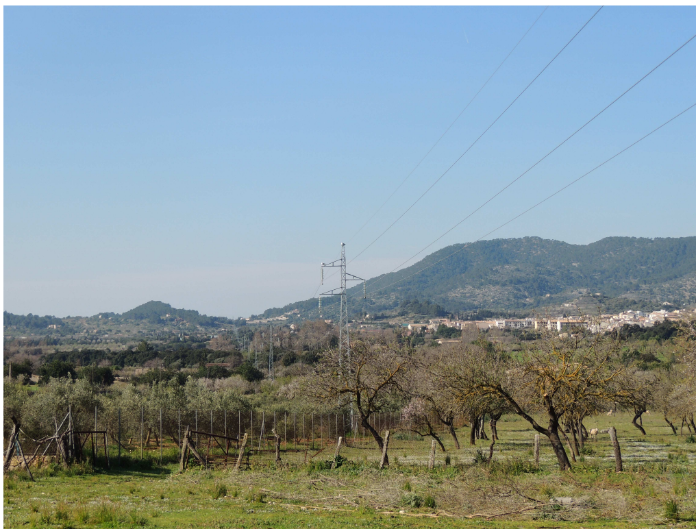
FOTOGRAFIA 12. La línea aérea de Inca a Bunyola cerca del núcleo de Alaró (apoyos T-53 y siguientes).
