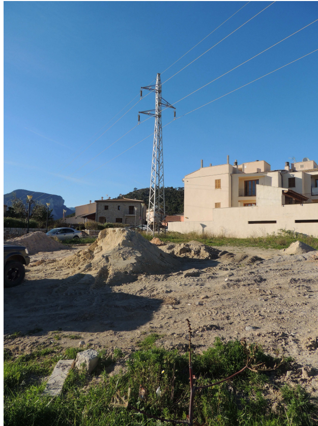
FOTOGRAFIA 5. La línea existente en su paso por el núcleo de Lloseta, atravesando una zona residencial parcialmente sin consolidar (apoyo T-29)
