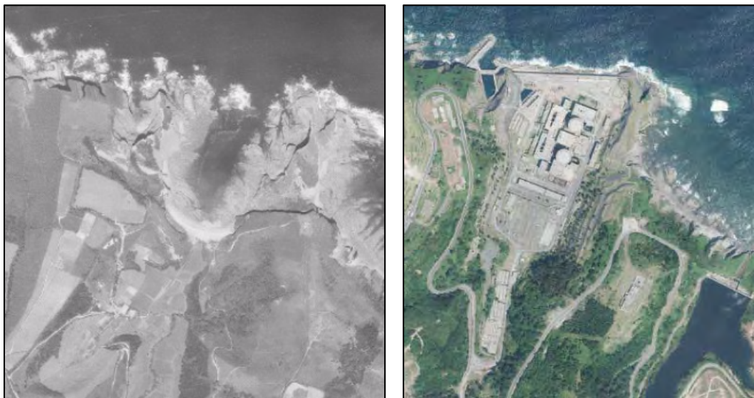
Figura 44. - Comparación de la zona antes de la instalación de la Central (1965) y después de la instalación de la misma (2015)
