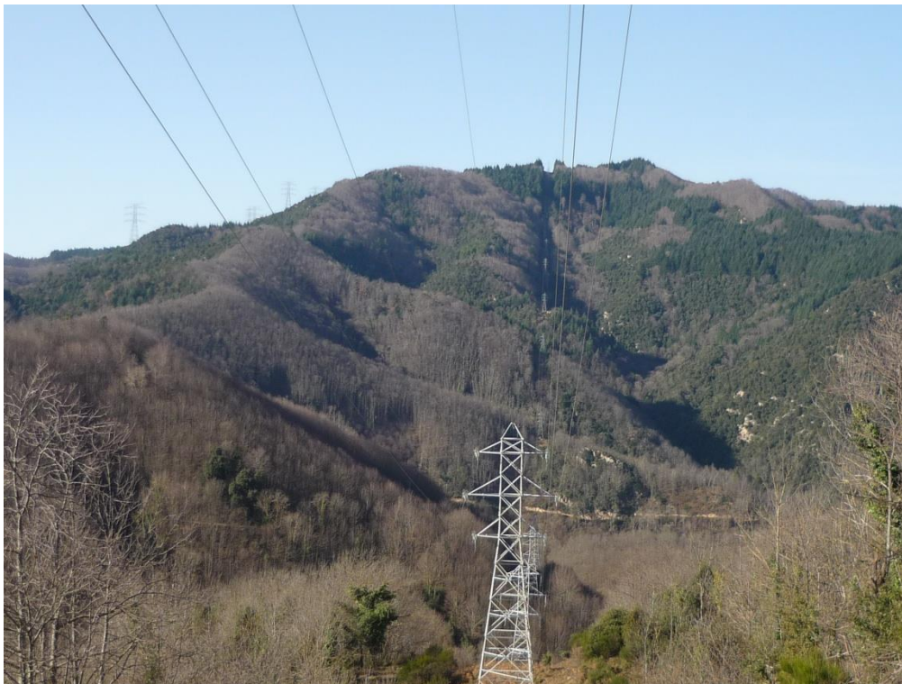
Perspectiva de un tramo de la instalación a desmantelar
