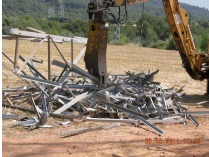
Foto 14. Fuente: Red Eléctrica
