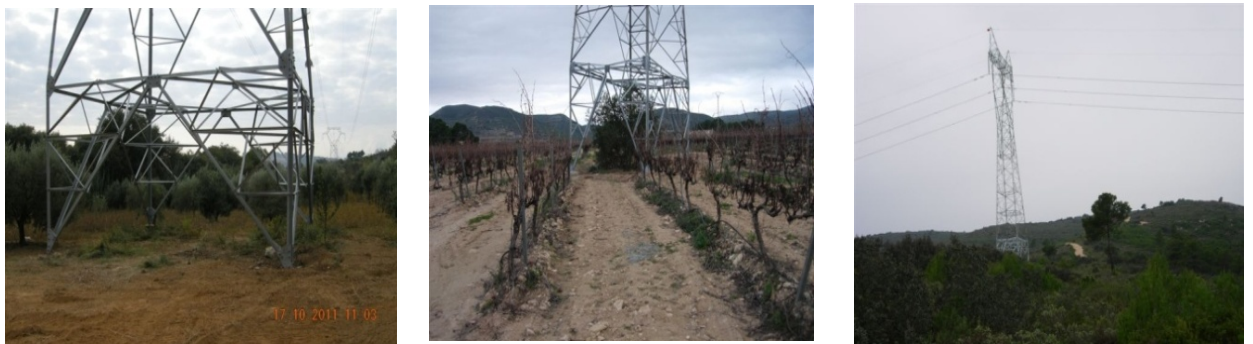
Foto 12. Situación final. Fuente: Red Eléctrica.
