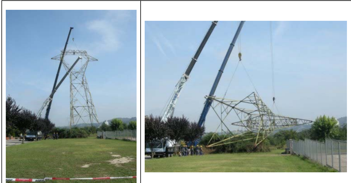
Foto 15. Fuente: Red Eléctrica
