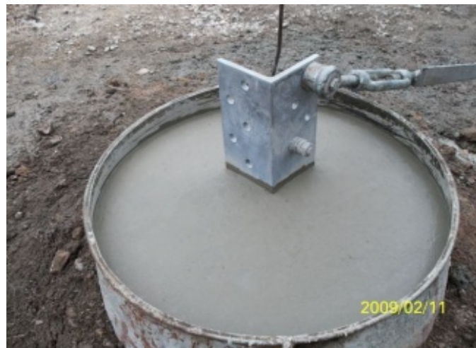
Foto 10. Ejemplo de hormigonado de las peanas. Fuente: Red Eléctrica
