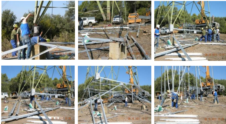
Foto 8. Ejemplo de tareas para ejecutar el recambio de los apoyos. Fuente: Red Eléctrica
