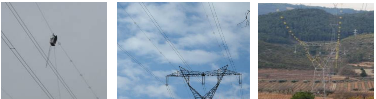
Foto 11. Instalación de salvapájaros. Fuente: Red Eléctrica
