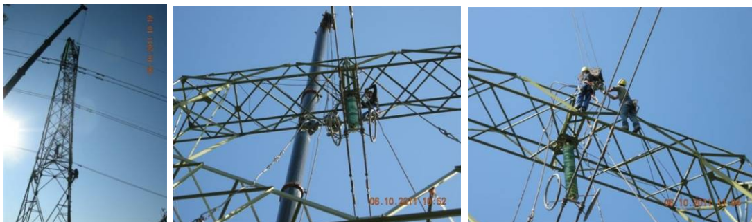
Foto 6. Ejemplo de tareas para ejecutar el recrecido de los apoyos. Fuente: Red Eléctrica
