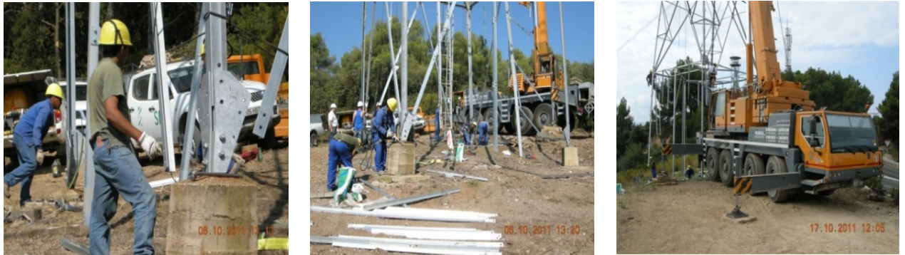
Foto 9. Ejemplo de tareas para ejecutar el recrecido de los apoyos. Fuente: Red Eléctrica
