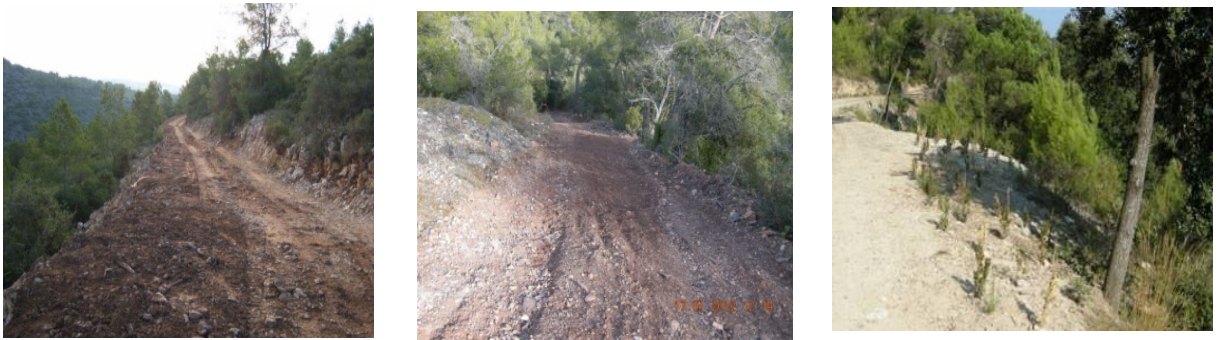
Foto 13. Situación final. Fuente: Red Eléctrica.
