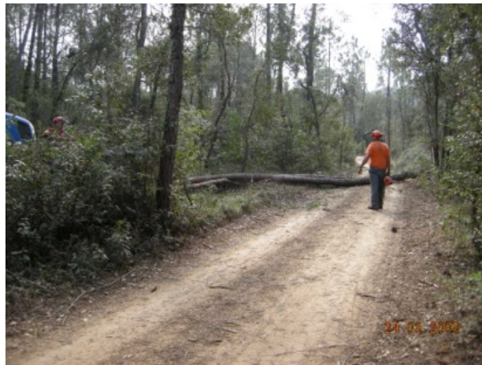
Foto 1. Ejemplo de trabajos de tala para adecuación de accesos. Fuente Red Eléctrica
