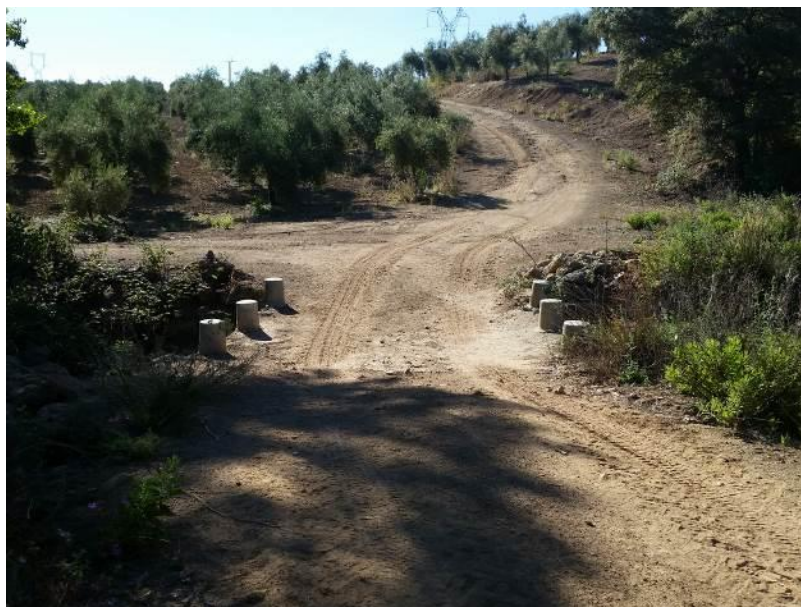
Fotografía 6. Puente para el cruce del Arroyo de Galbán .
