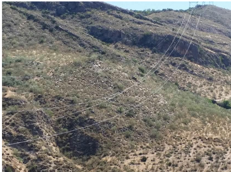
Fotografía 9. Zona de rebaje entre los apoyos T-141 y T-142.
