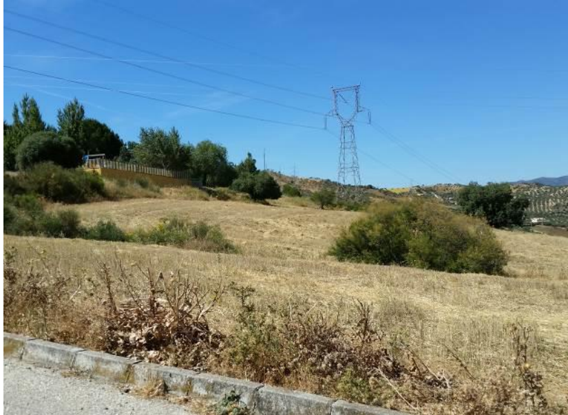
Fotografía 5. Acceso T-15 al fondo y perpendicularmente en la zona de taray la rambla sin denominación a cruzar.
