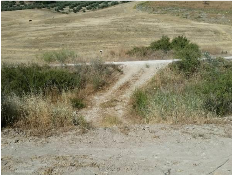
Fotografía 7. Badén para el cruce del Arroyo de los Pinares.
