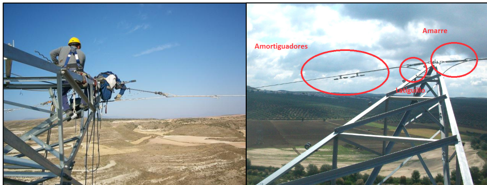
Fotografías 21 y 22. Colocación varilla preformada. Conjunto amarre.
