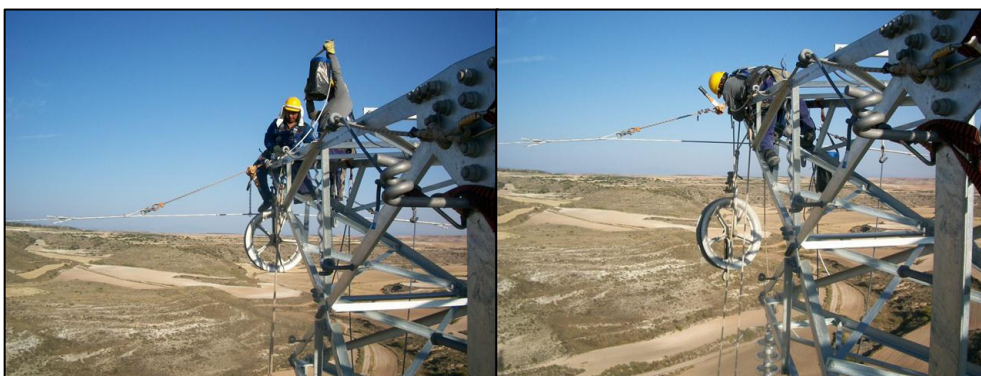
Fotografías 19 y 20. Sujeción del cable tendido en poleas y retirada de polea.
