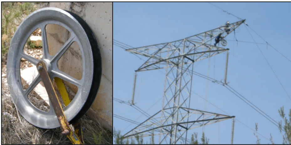
Fotografías 11 y 12. Detalle de una polea y tendido de cables (en el ejemplo de la imagen, cable de tierra).
