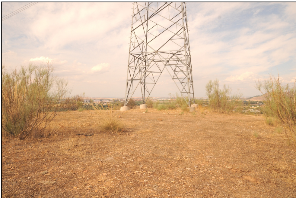
Fotografía 23. El entorno del apoyo T-16 dispone de superficies casi llanas y despejadas para la maniobra de la maquinaria necesaria para ejecutar la sustitución del mismo.
