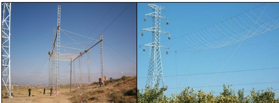
Fotografías 9 y 10. Instalación de poleas en crucetas
