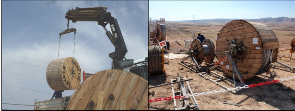
Fotografías 13 y 14. Descarga de bobina en obra y situación de la bobina detrás de la máquina de freno.
