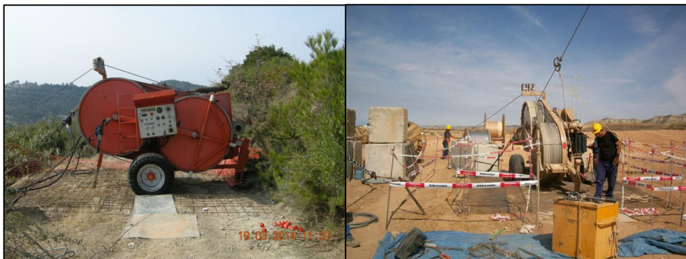
Fotografías 15 y 16. Ubicación de máquina en caminos y situación de la bobina.
