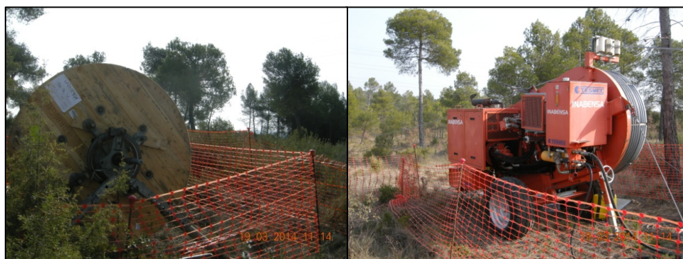
Fotografías 17 y 18. Ubicación de máquina y bobina en zona forestal.
