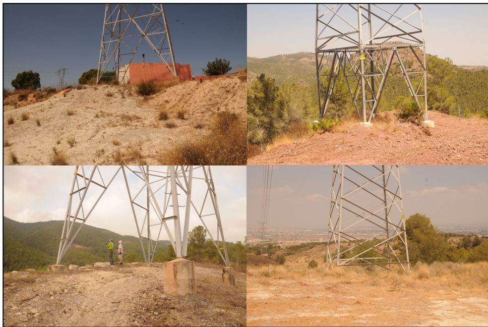
Fotografía 5. Superficies alteradas en el entorno de algunos de los apoyos: T-93 (imagen superior izquierda), T-101 (superior derecha), T-104 (inferior izquierda) y T-106 (inferior derecha).
