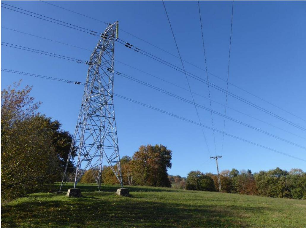
Foto 8. Apoyo T14, que se recrece 4 m por cruzamiento con línea de baja tensión.
