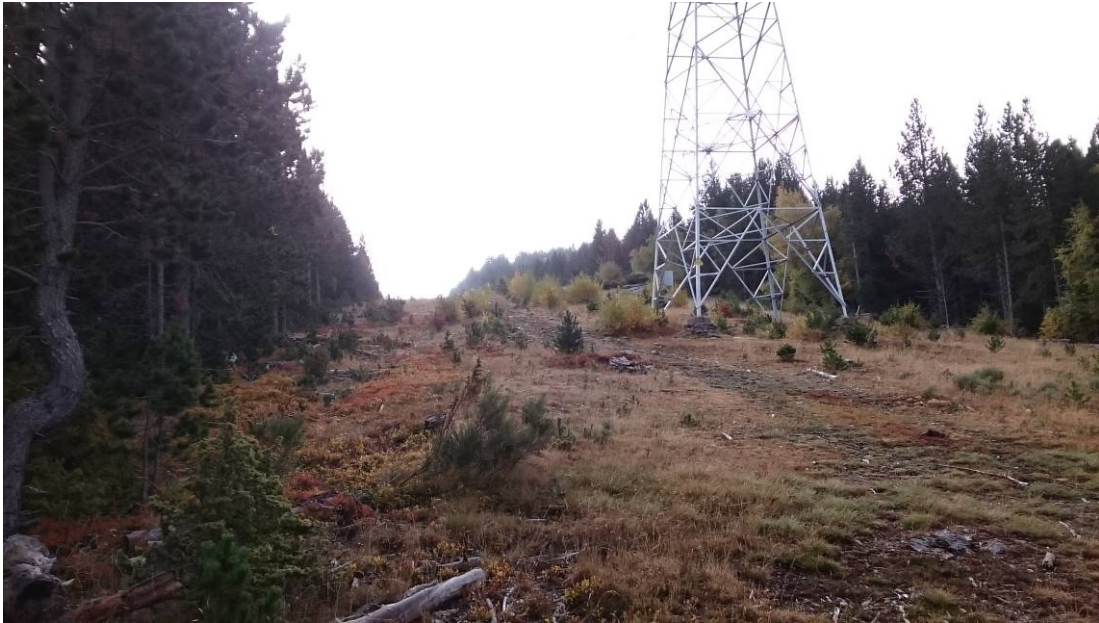
Foto 29. Vista del acceso al apoyo 45 desde el apoyo 44, por la calle de seguridad de la línea eléctrica
