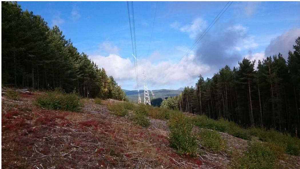
Foto 23. Vista del vano 72-73, donde se aprecia la distancia del conductor al suelo, donde habría que actuar en la alternativa de rebaje de terreno
