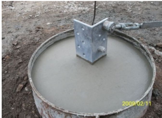
Foto 11. Ejemplo de hormigonado de las peanas. Fuente: Red Eléctrica
