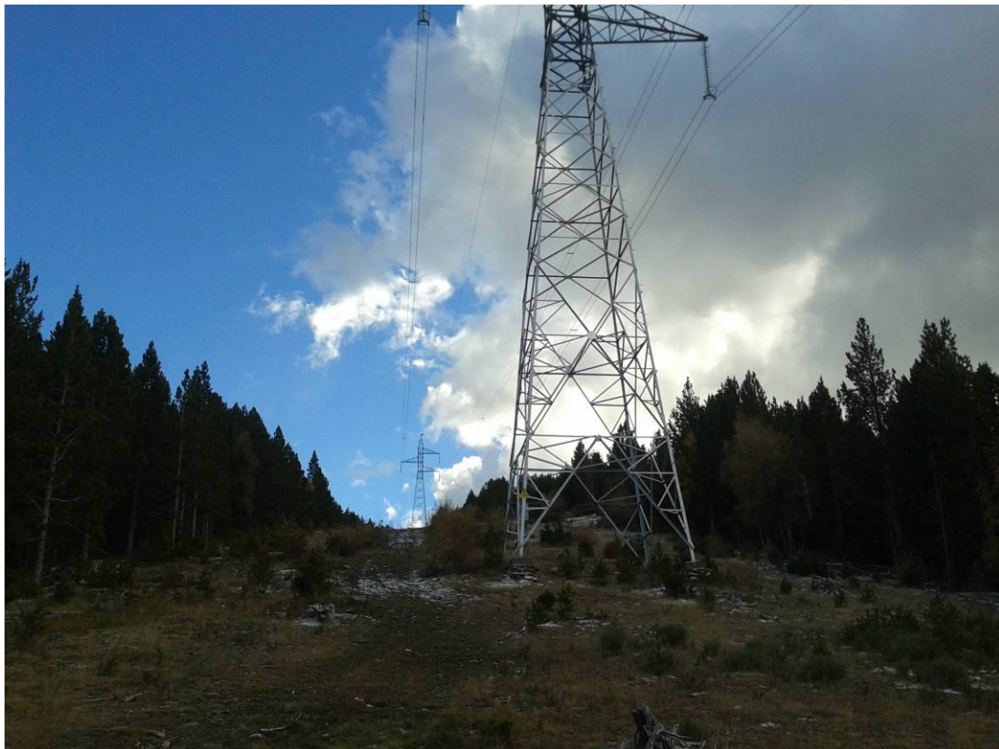
Foto 24. Al fondo, vista del apoyo 45. En primer término, apoyo 44, que dispone de acceso existente. Desde éste, el acceso se realizaría bajo línea hasta el apoyo 45.
