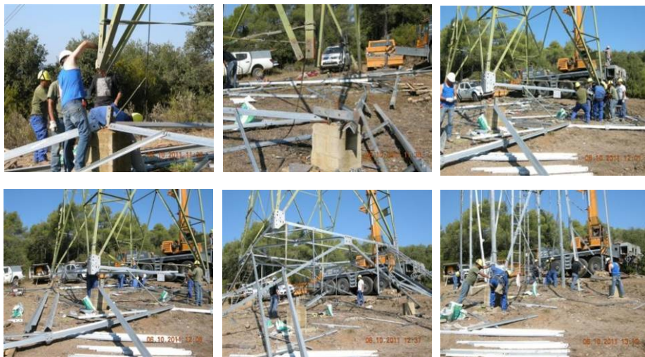
Foto 9. Ejemplo de tareas para ejecutar el recrecido de los apoyos. Fuente: Red Eléctrica
