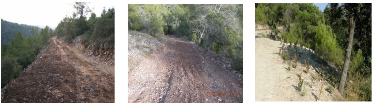
Foto 14. Situación final. Fuente: Red Eléctrica.
