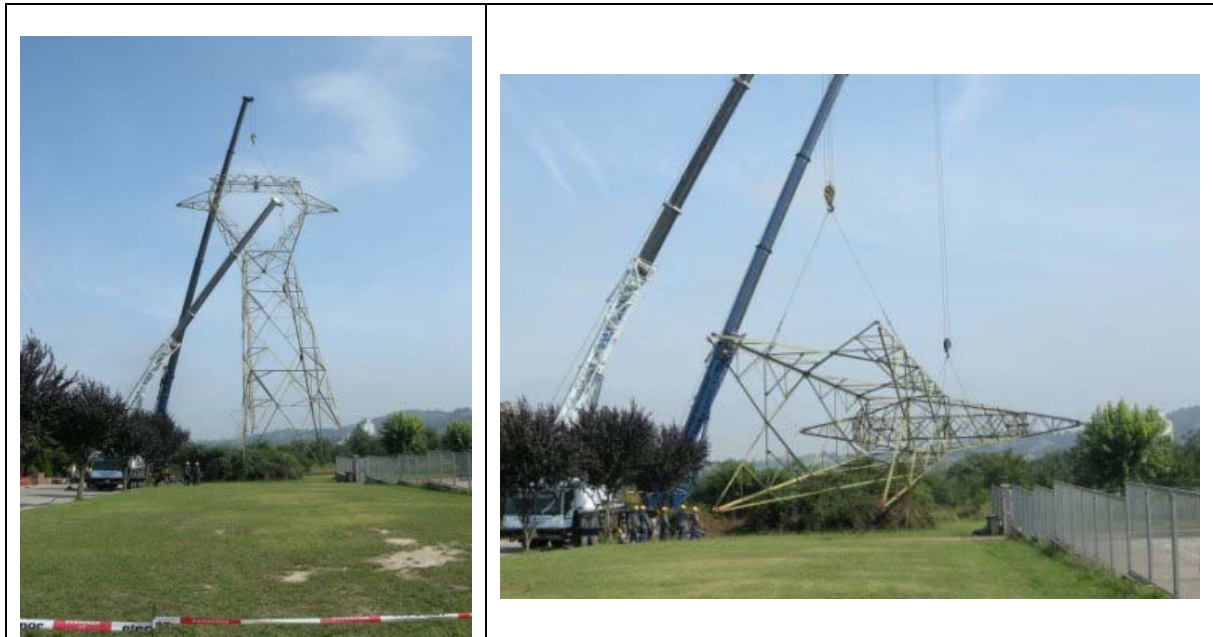
Foto 16. Fuente: Red Eléctrica
