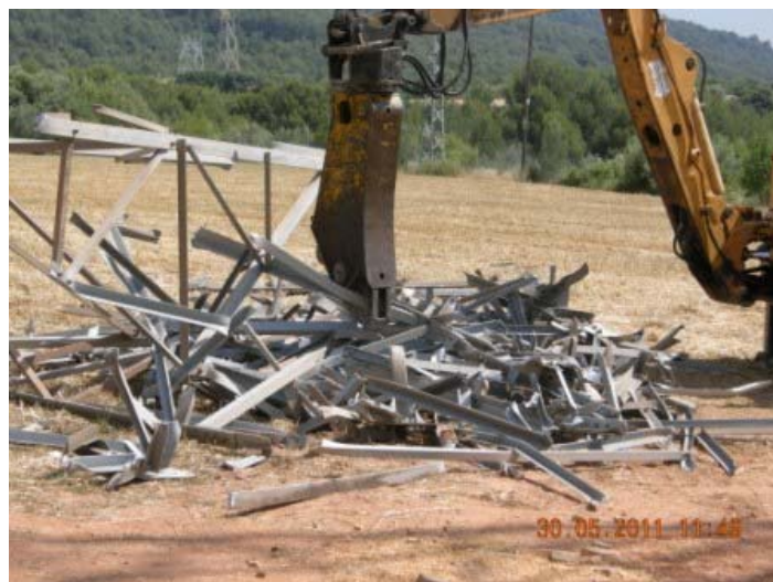
Foto 15. Fuente: Red Eléctrica
