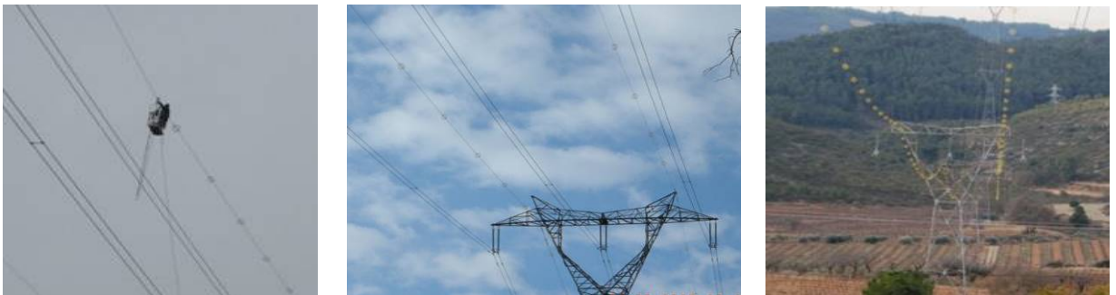
Foto 12. Instalación de salvapájaros. Fuente: Red Eléctrica
