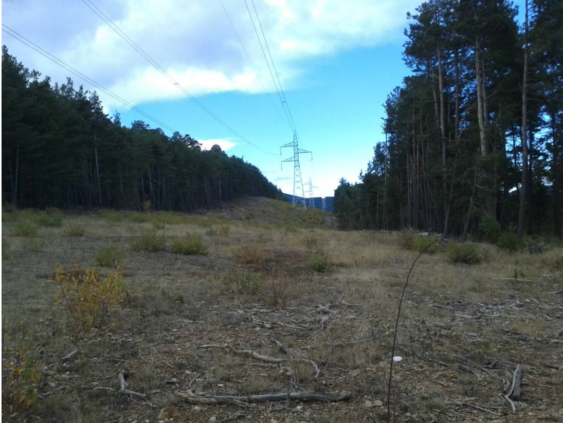
Foto 22. Vista del apoyo y la calle
