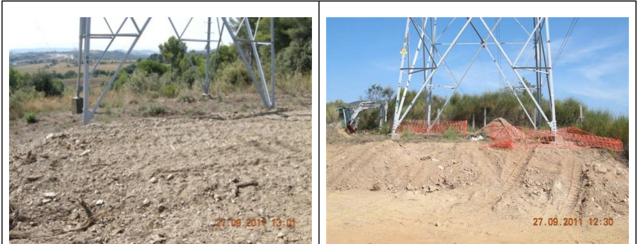
Foto 4. Ejemplo de adecuación de la plataforma. Fuente: Red Eléctrica
