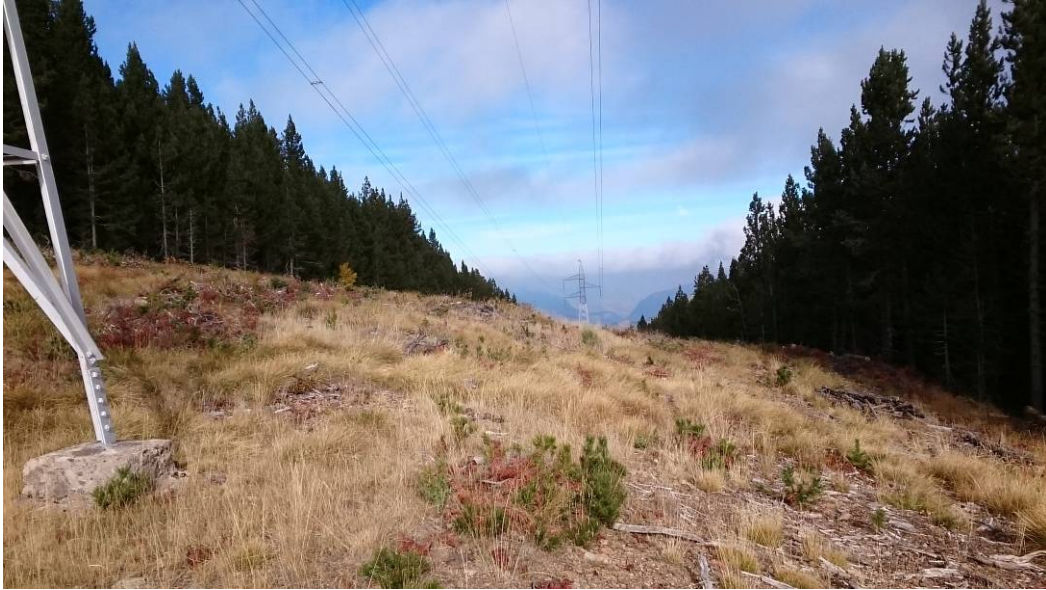
Foto 25. Vista desde el apoyo 46. Al fondo el apoyo 45. Se observan las distancias del conductor al suelo, en el tramo donde habría que actuar en la alternativa de rebaje de terreno.
