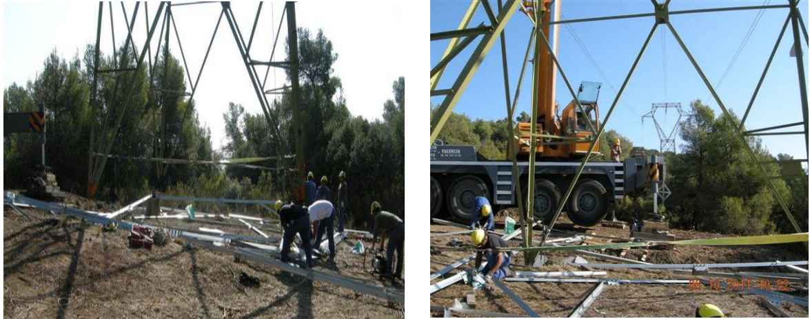
Foto 5. Ejemplo de tareas para ejecutar el recrecido de los apoyos. Fuente: Red Eléctrica
