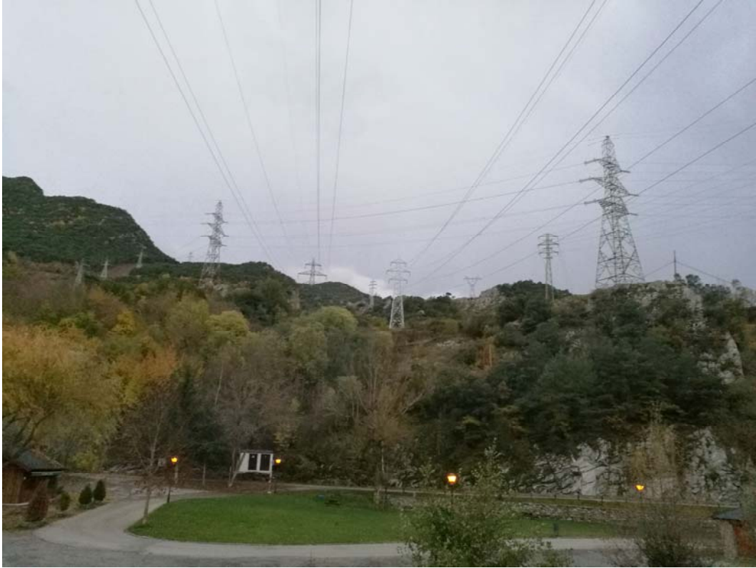
Foto 30. Perspectiva actual del apoyo 40 desde Llavorsí.
