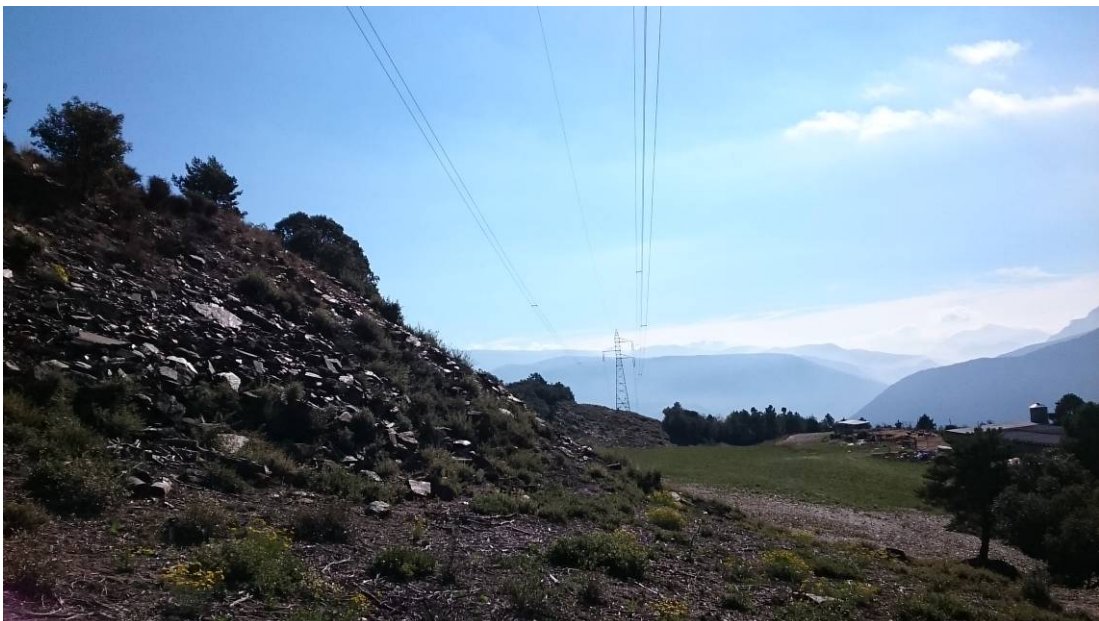
Foto 21. En la imagen se observa el apoyo 104, desde el apoyo 103. A la izquierda, el talud de la N-260
