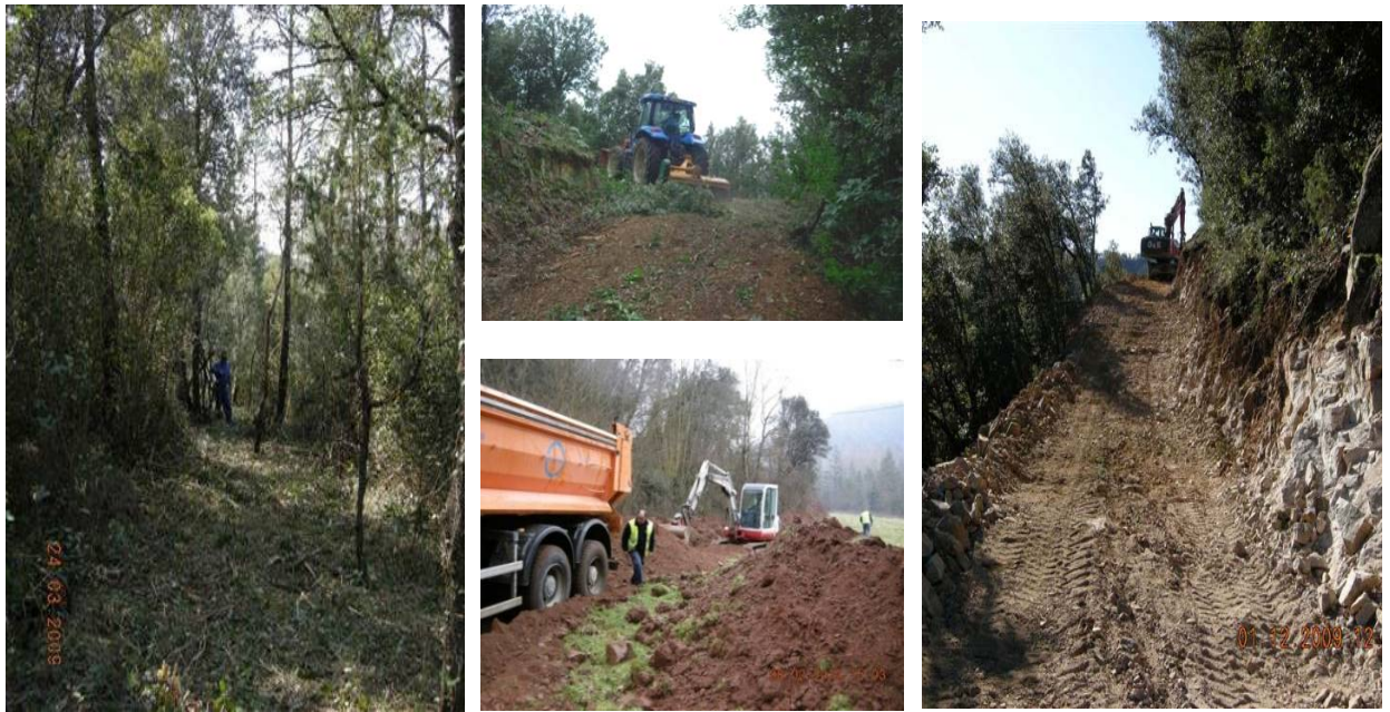
Foto 3. Fase de construcción de nuevo acceso. Fuente: Red Eléctrica
