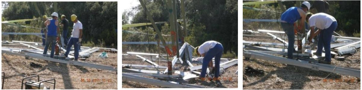
Foto 8. Ejemplo de tareas para ejecutar el recrecido de los apoyos. Fuente Red Eléctrica
