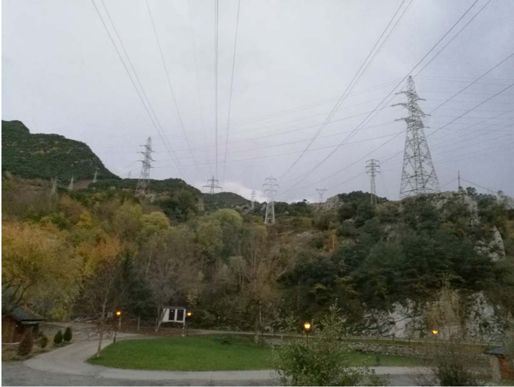
Foto 31. Perspectiva actual del apoyo 40 desde Llavorsí.
