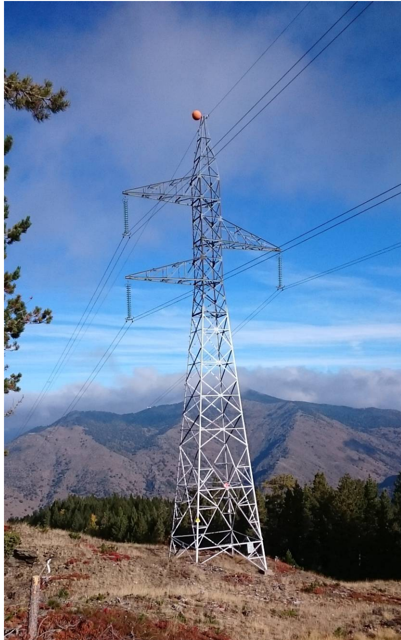
Foto 1. Tipo de apoyo entre tramo entre Llavorsi y el apoyo 107
