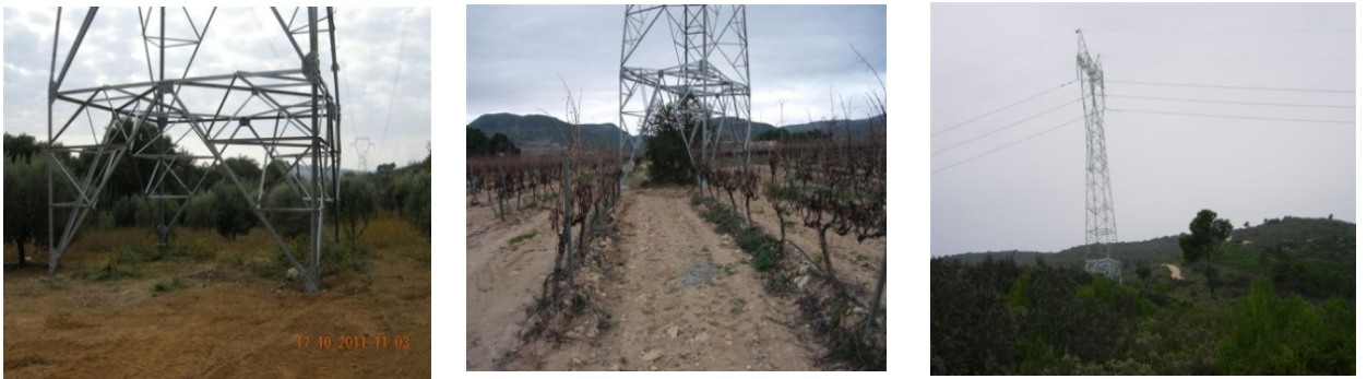
Foto 13. Situación final. Fuente: Red Eléctrica.
