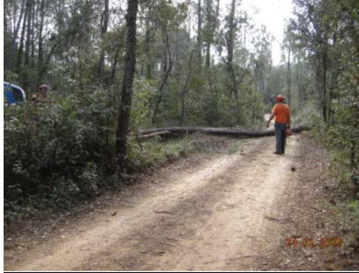
Foto 1. Ejemplo de trabajos de tala para adecuación de accesos. Fuente Red Eléctrica
