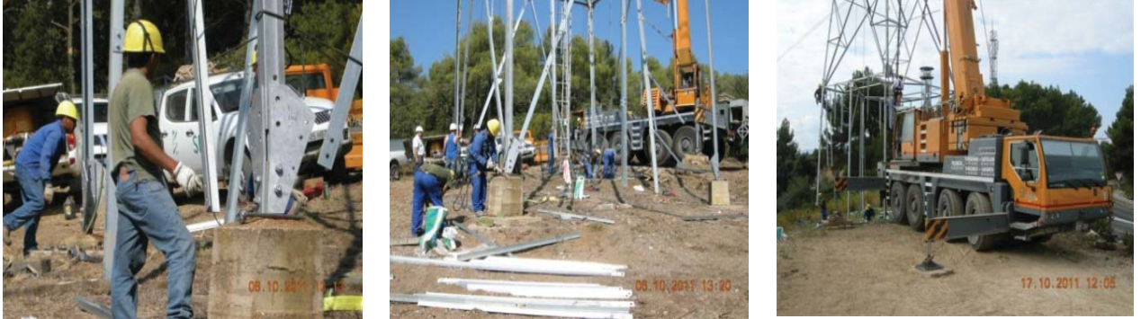
Foto 8. Ejemplo de tareas para ejecutar el recrecido de los apoyos. Fuente: Red Eléctrica
