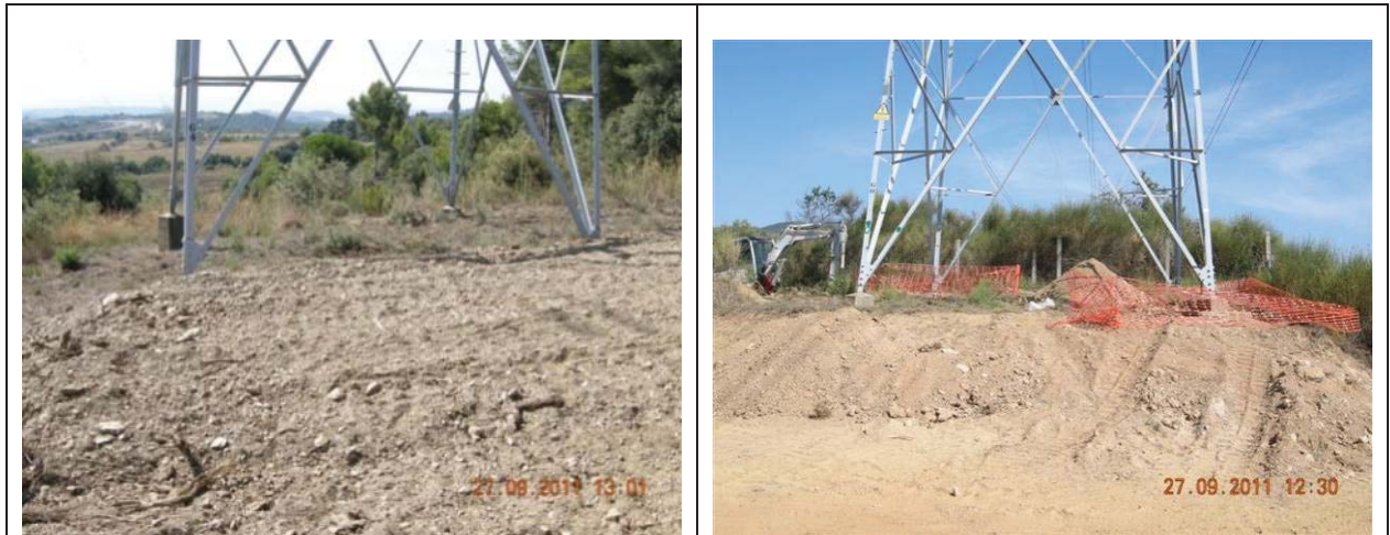
Foto 3. Ejemplo de adecuación de la plataforma. Fuente: Red Eléctrica
