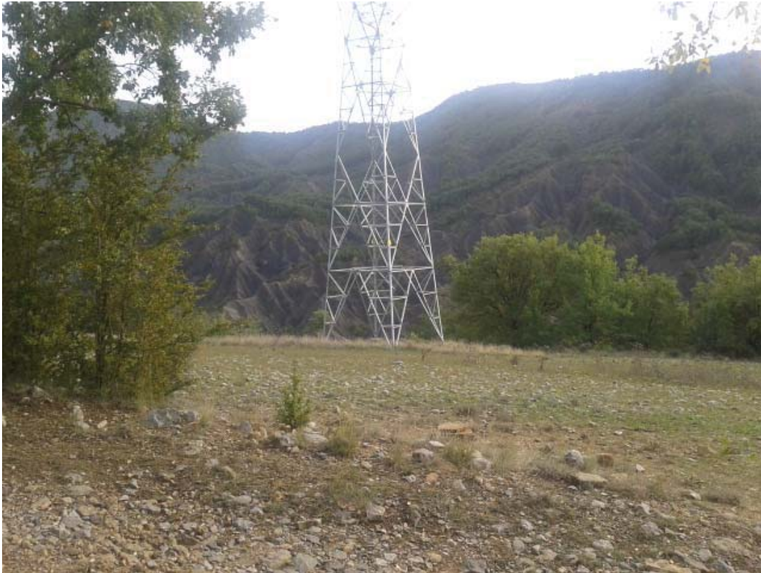
Foto 13. Acceso al apoyo T135
