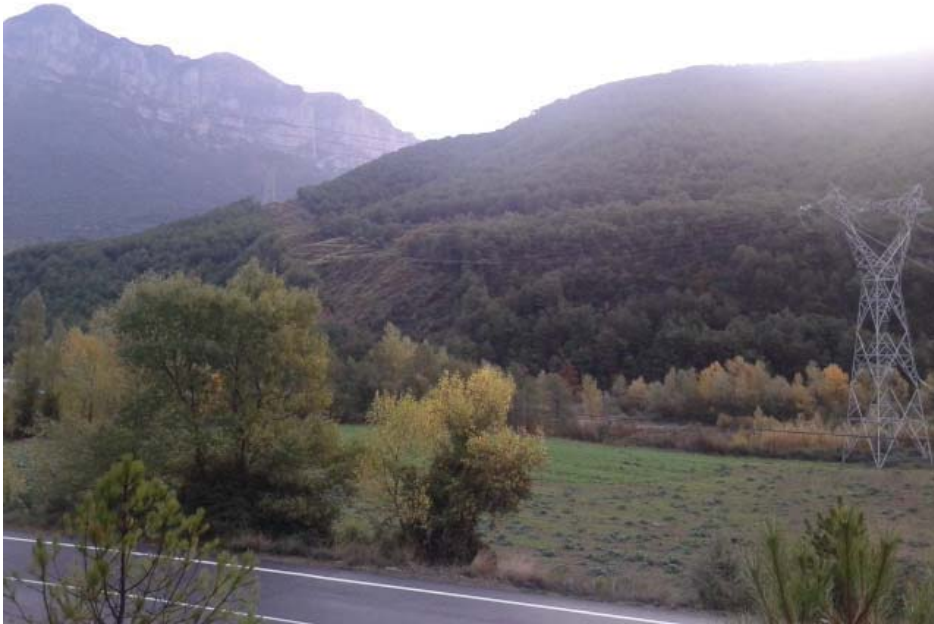
Foto 18. Perspectiva actual del apoyo 164 desde la carretera A-138
