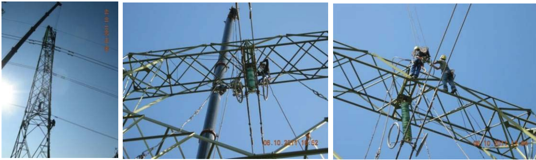
Foto 5. Ejemplo de tareas para ejecutar el recrecido de los apoyos. Fuente: Red Eléctrica
