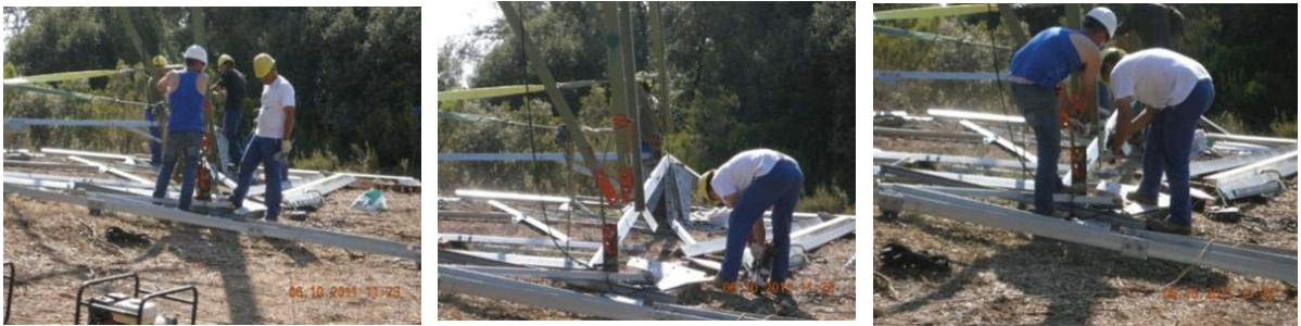
Foto 6. Ejemplo de tareas para ejecutar el recrecido de los apoyos. Fuente: Red Eléctrica
