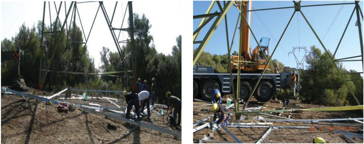
Foto 4. Ejemplo de tareas para ejecutar el recrecido de los apoyos. Fuente: Red Eléctrica
