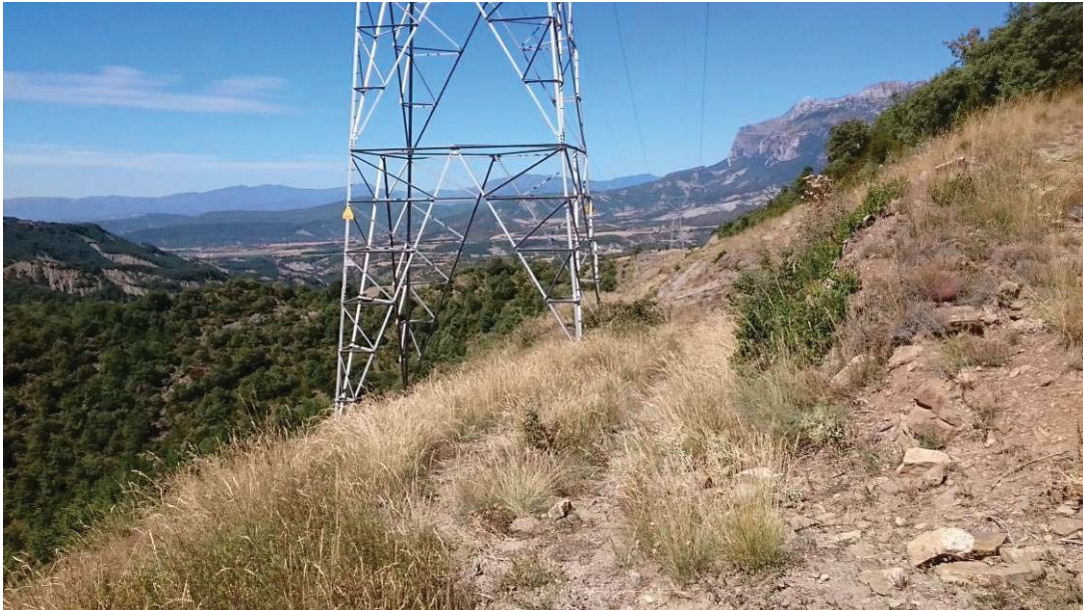
Foto 11. Vista del apoyo 129, con acceso existente hasta su base. Requerirá algún movimiento de tierras localizado alrededor de la plataforma para ubicar la grúa. Al fondo, el apoyo 130.
