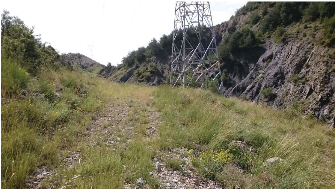
Foto 10. Apoyo 128: con acceso existente y espacio para ubicar grúa
