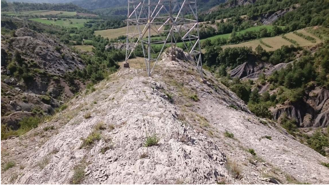
Foto 9. Apoyo 127: ubicado en un risco rocoso sin acceso para maquinaria
