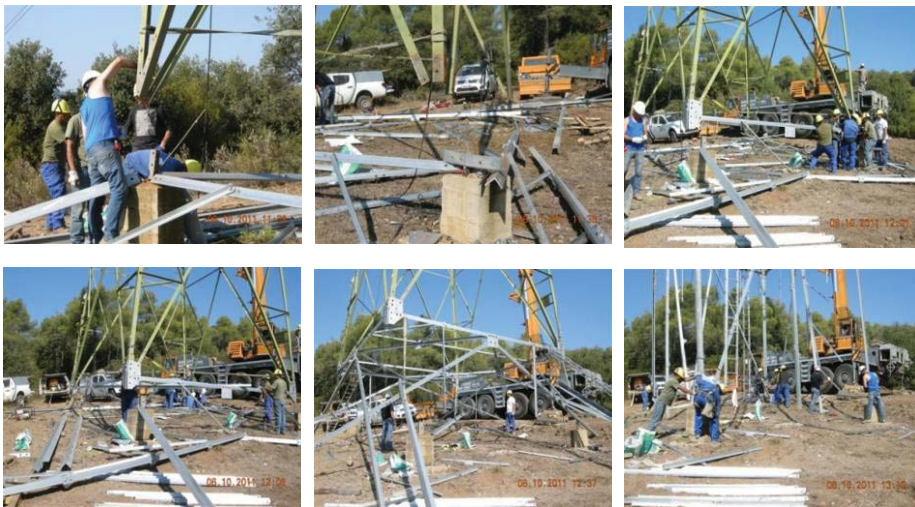
Foto 7. Ejemplo de tareas para ejecutar el recrecido de los apoyos. Fuente: Red Eléctrica
