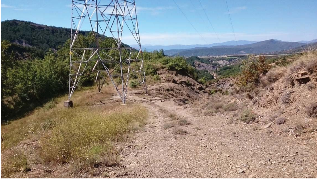
Foto 12. Vista del apoyo 132, que dispone de acceso y de espacio para ubicar grúa en sus inmediaciones
