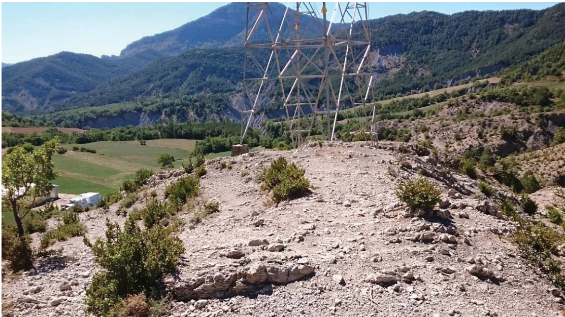
Foto 8. Vista del emplazamiento del apoyo 125.
