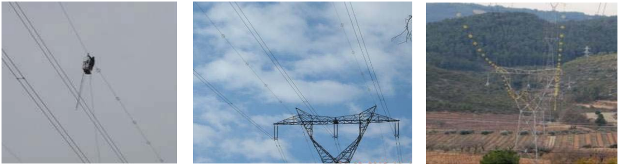
Foto 1. Instalación de salvapájaros. Fuente: Red Eléctrica
