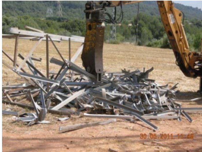
Foto 4. Fuente: Red Eléctrica
