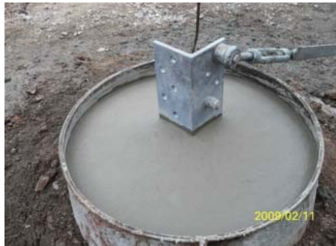
Foto 9. Ejemplo de hormigonado de las peanas. Fuente: Red Eléctrica
