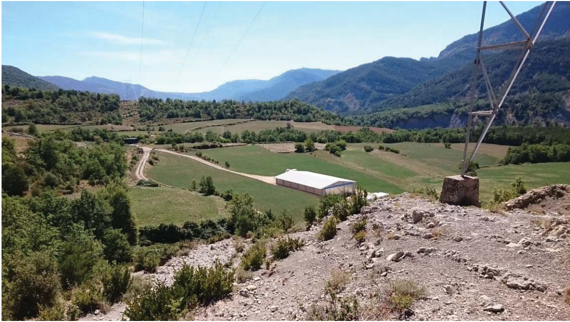
Foto 7. Vista del vano 124-125, realizada desde el apoyo 125. Al fondo, el apoyo 124.
