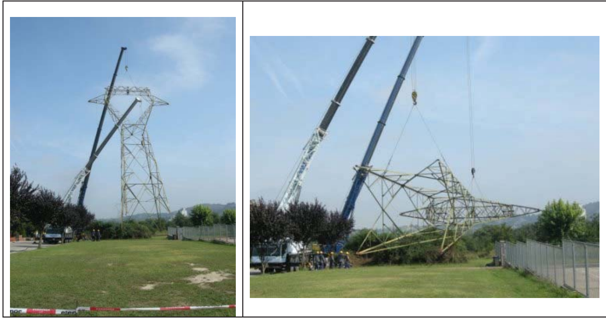
Foto 5. Fuente: Red Eléctrica
