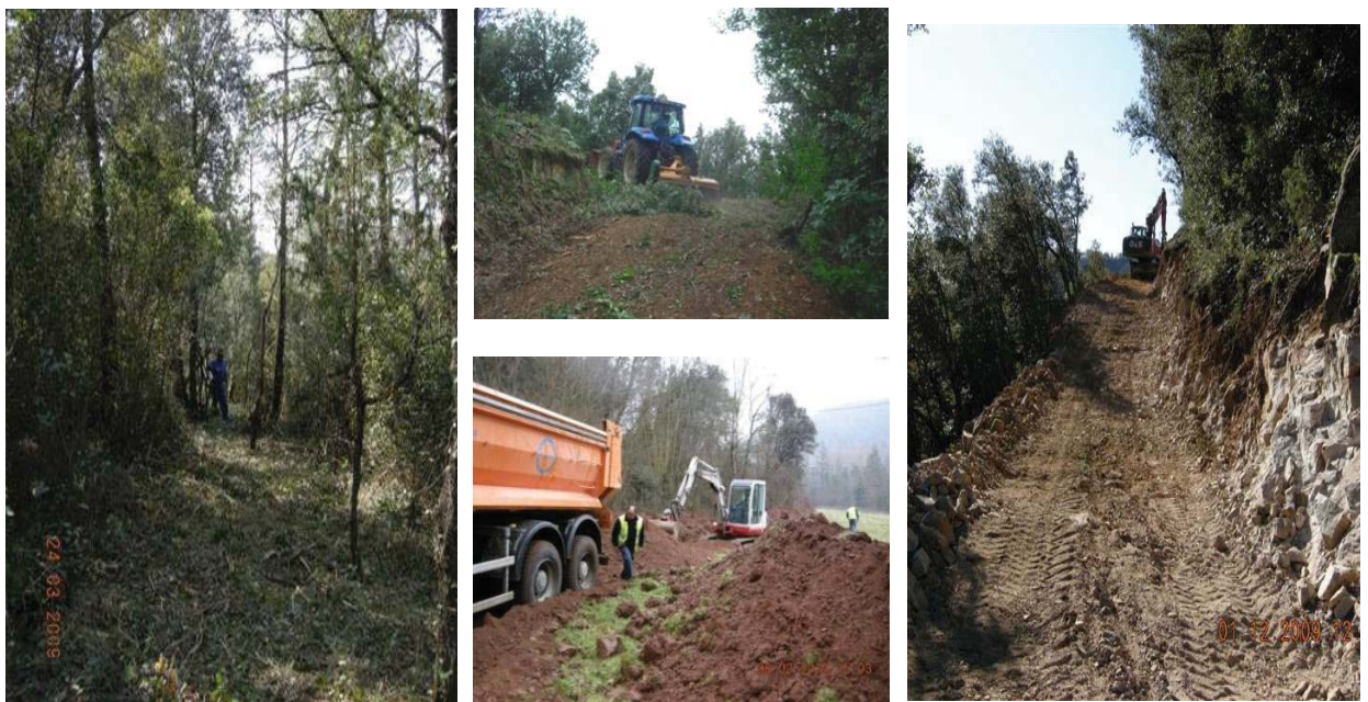
Foto 2. Ejemplo de construcción de nuevo acceso. Fuente: Red Eléctrica
